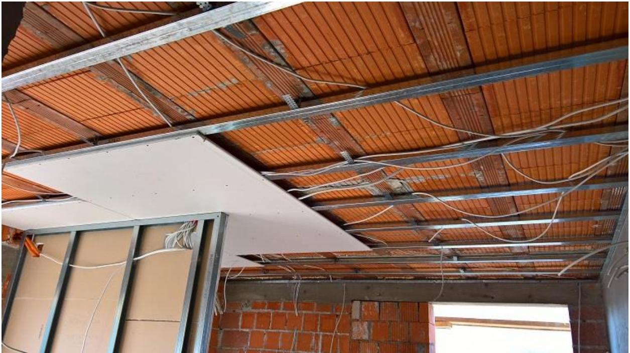
*Slika 5.4. Spušteni strop izveden sa direktnim ovjesom*
