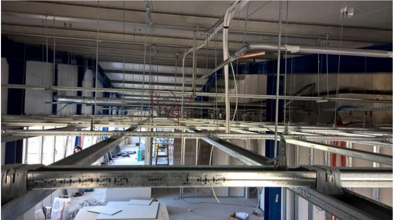
Slika 5.7. Dupla metalna podkonstrukcija ovješena na sidreni ovjes
