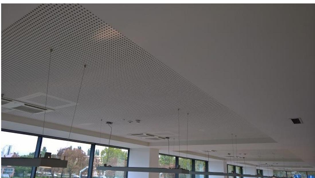
Slika 6.8. Akustični strop u kombinaciji s klasičnim spuštenim stropom
