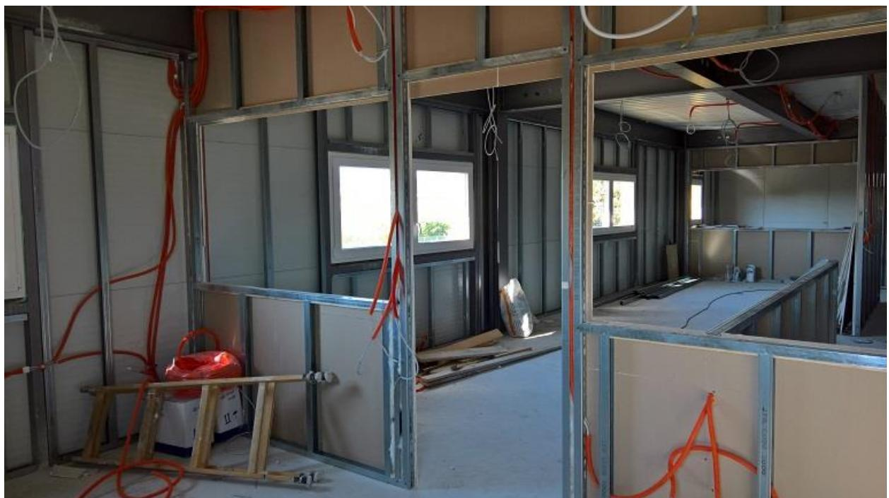
Slika 4.1. Izvedba suhomontažnih pregradnih zidova W112
