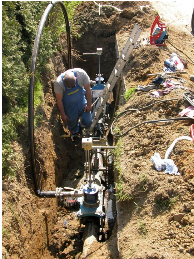
Slika 5.3 Prikaz radova sanacije na PE plinovodu
