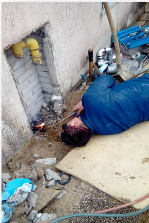
Slika 5.4 Prikaz radova u tijeku sanacije propusnosti spojnog seta
