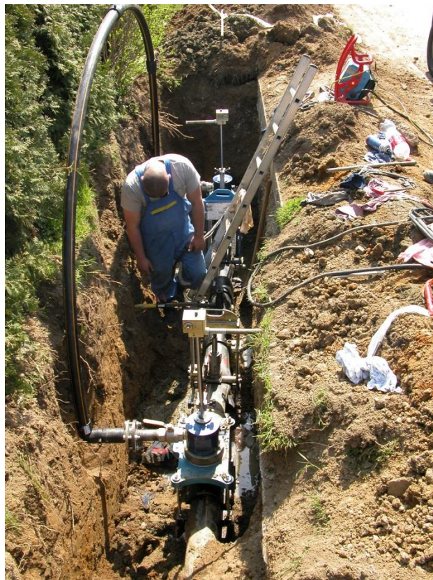
Slika 5.3 Prikaz radova sanacije na PE plinovodu
