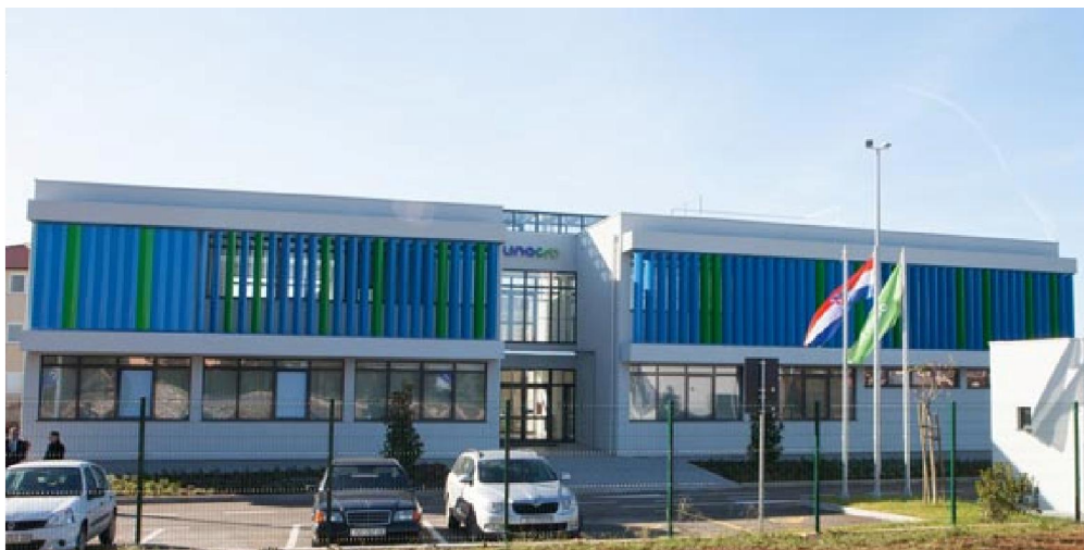
Slika 32 Zgrada Plinacro u Vodnjanu
