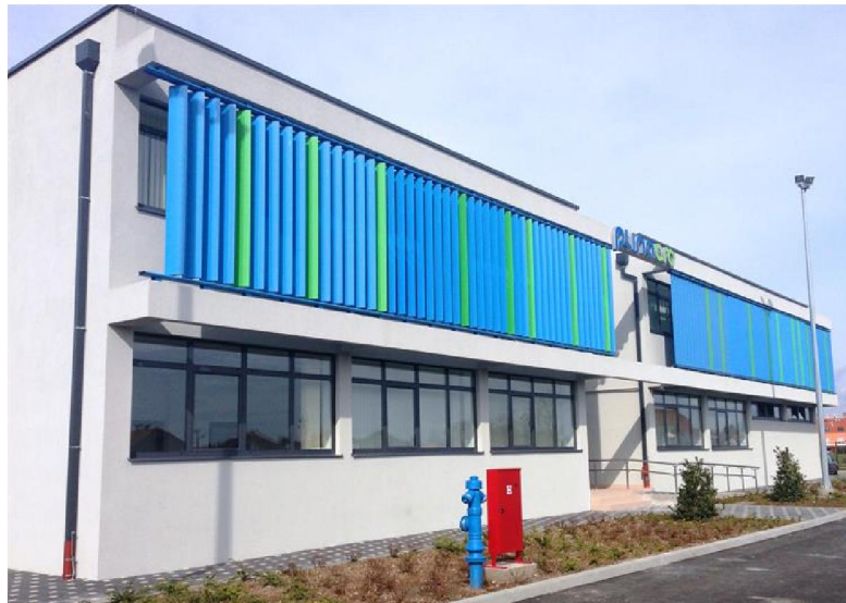
Slika 31 Zgrada Plinacro u Čakovcu
