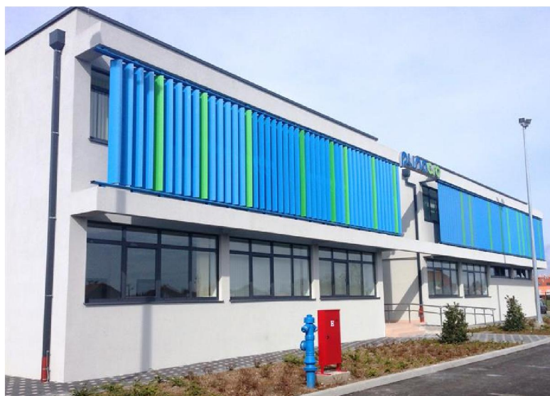
Slika 31 Zgrada Plinacro u Čakovcu
