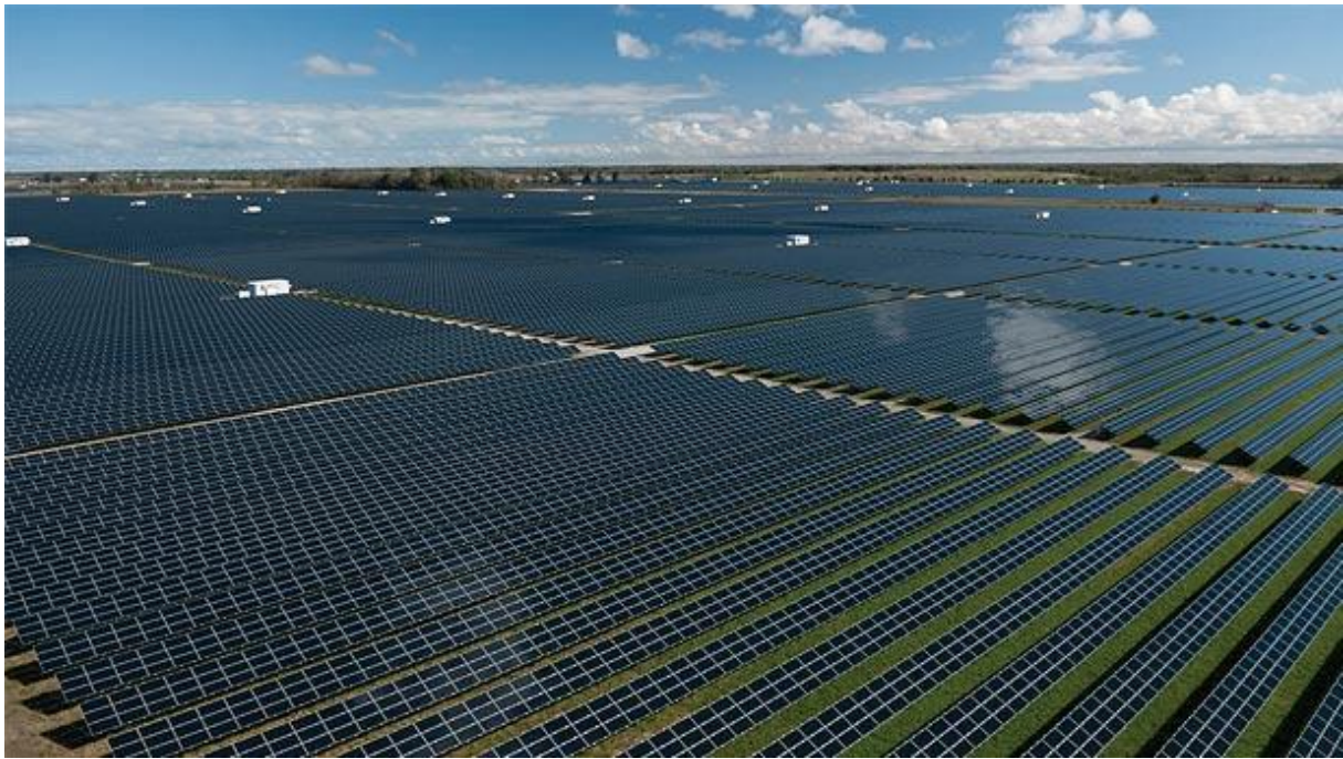
Slika 4.1. Solarna elektrana Topaz u Kaliforniji [44]
