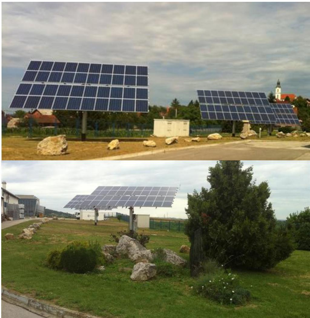
*Slika 5.6. Tracker solarna elektrana u Svetom Ilijii snage 25,2 kW [15]*
