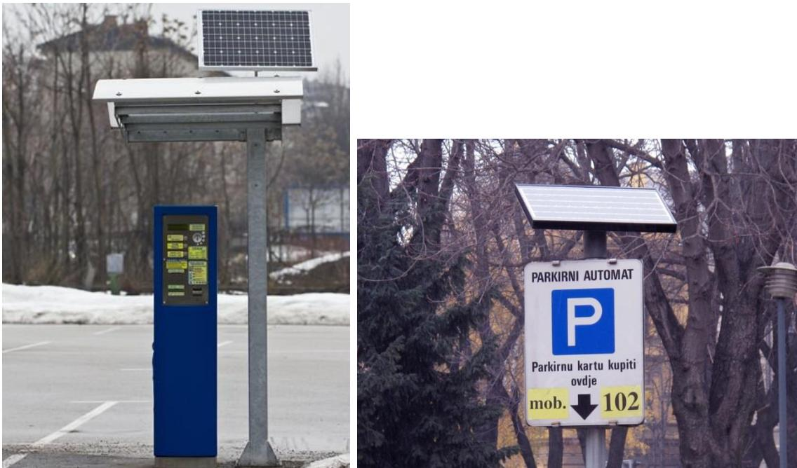
Slika 4.2. Parkirališni automati sa solarnim modulima [45]
