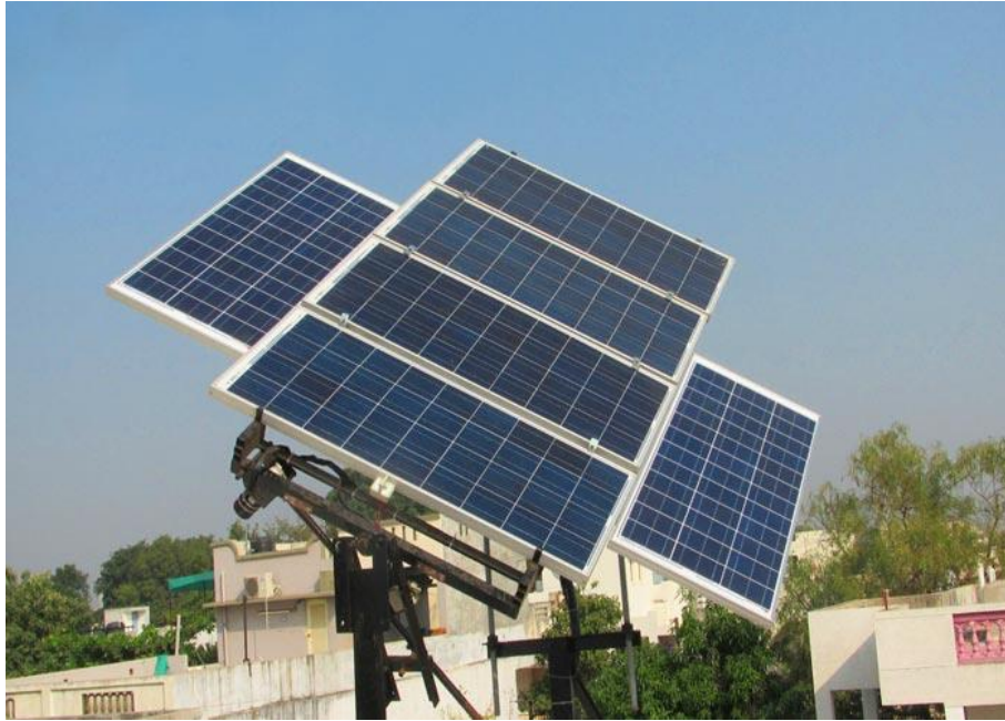
Slika 3.6. Fotonaponski sustav koji prati kretanje Sunca [42]
