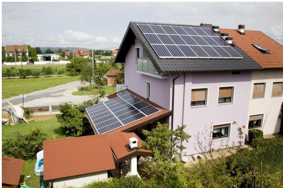
*Slika 5.2. Fiksno postavljeni solarni paneli na krovu kuće [50]*
