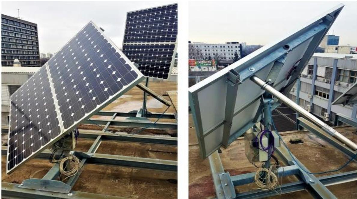
Slika 5.8. Solarni paneli na jednoosnom nosaču [52]
