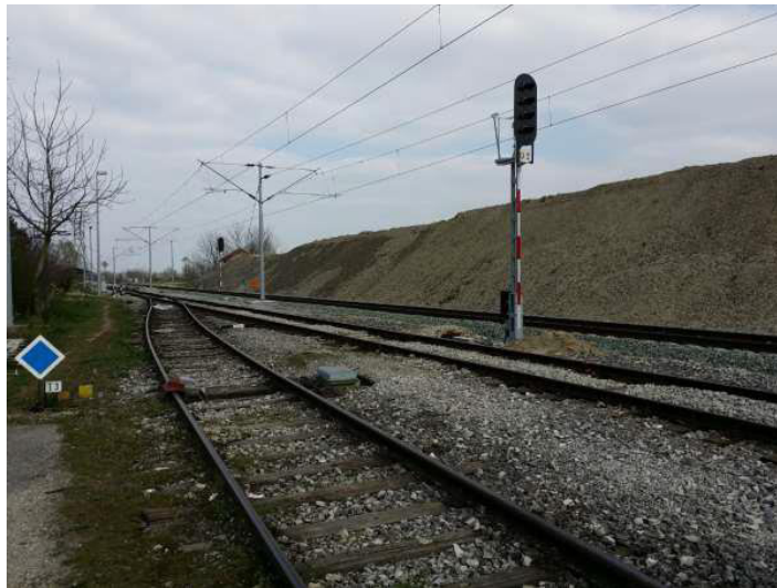
Slika 14a. Deponija kamenog agregata u kolodvoru Drnje [10]
