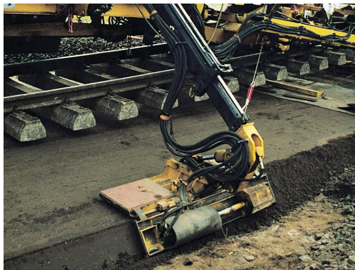
Slika 12. Završna faza uređenja novog konsolidiranog tamponskog sloja [9]
