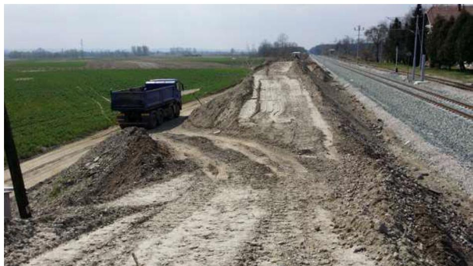
*Slika 15. Izgradnja paralelnog puta uz željezničku prugu [10]*
