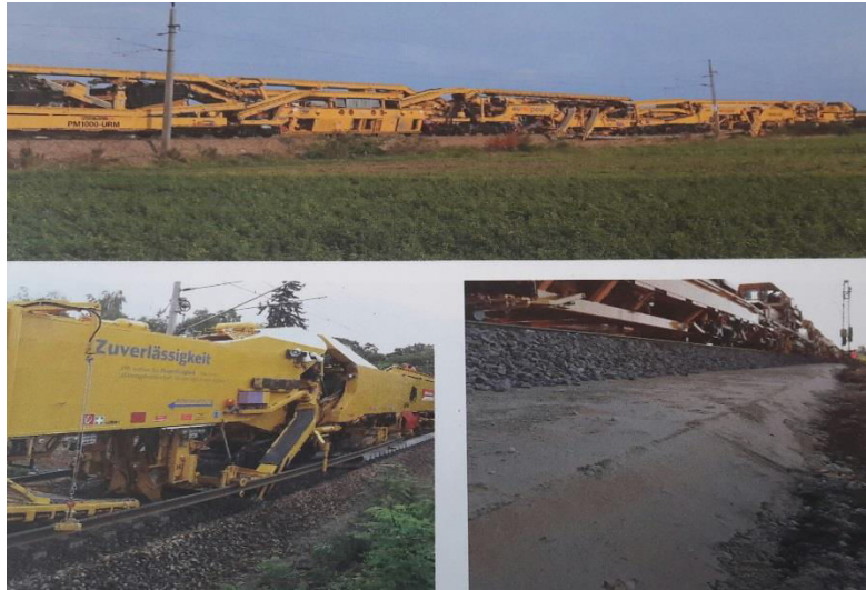
Na slici 3. Gradilište sa strojevima za obnovu pruga [8]
