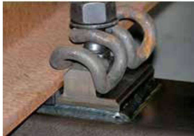
*Slika broj 25. Način spajanja čeličnih pragova i tračnica [15]*
