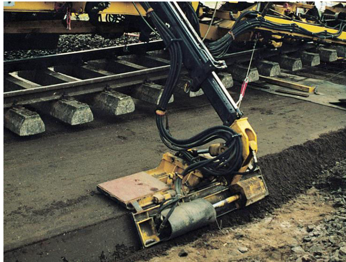
Slika 12. Završna faza uređenja novog konsolidiranog tamponskog sloja [9]
