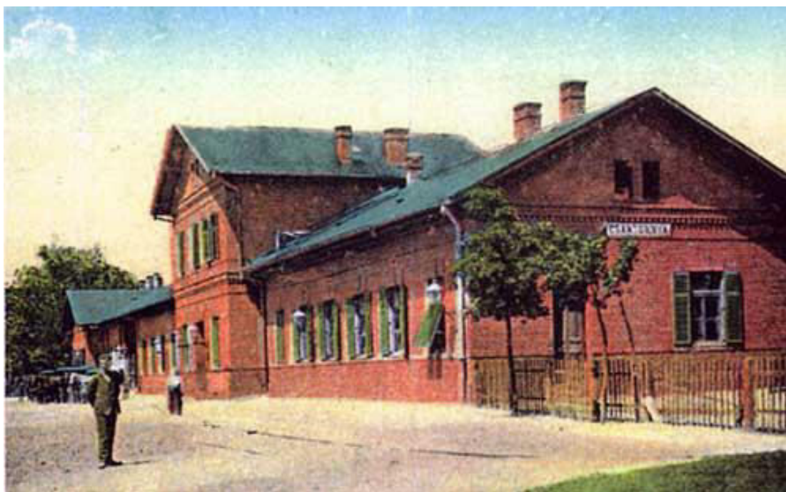
Slika 1. Čakovečki željeznički kolodvor nakon otvorenja željezničke pruge [1]
