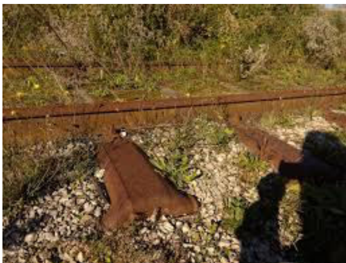
Slika broj 26. Čelični pragovi ugrađeni u kolosiječnu rešetku [16]
