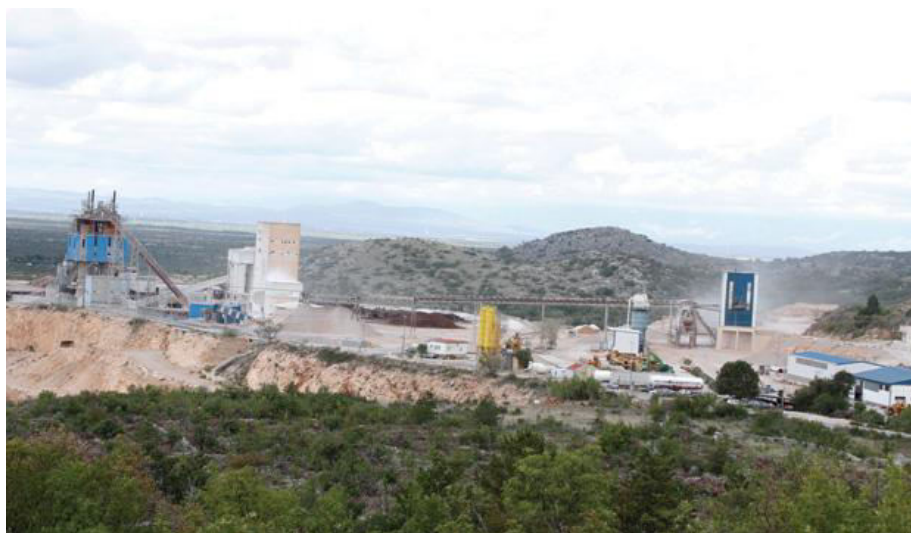
Slika 21. Postrojenja poduzeća GIRK Kalun d.d. iz Drniša [14]
