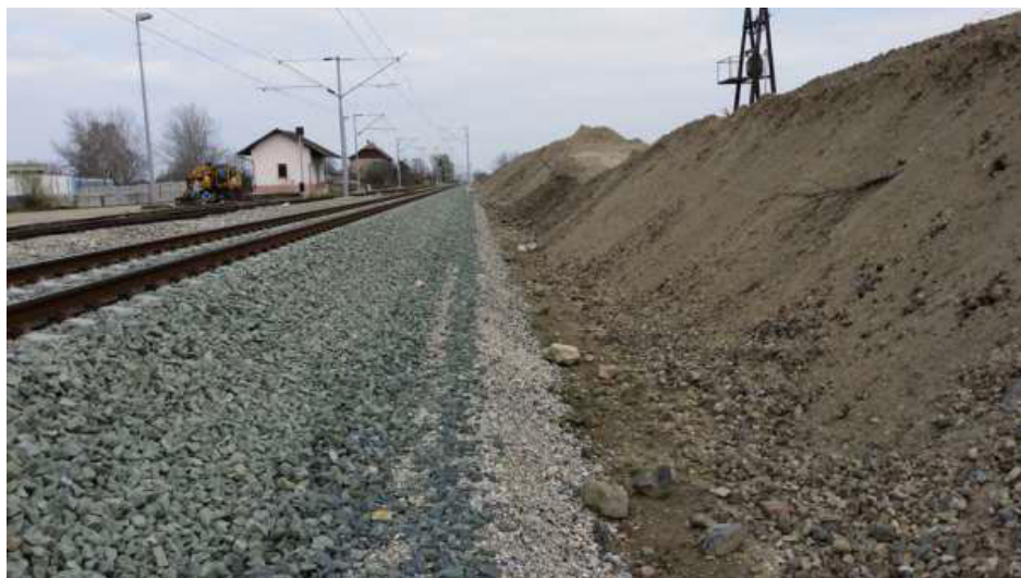
Slika 14b. Deponija kamenog agregata u kolodvoru Drnje [10]
