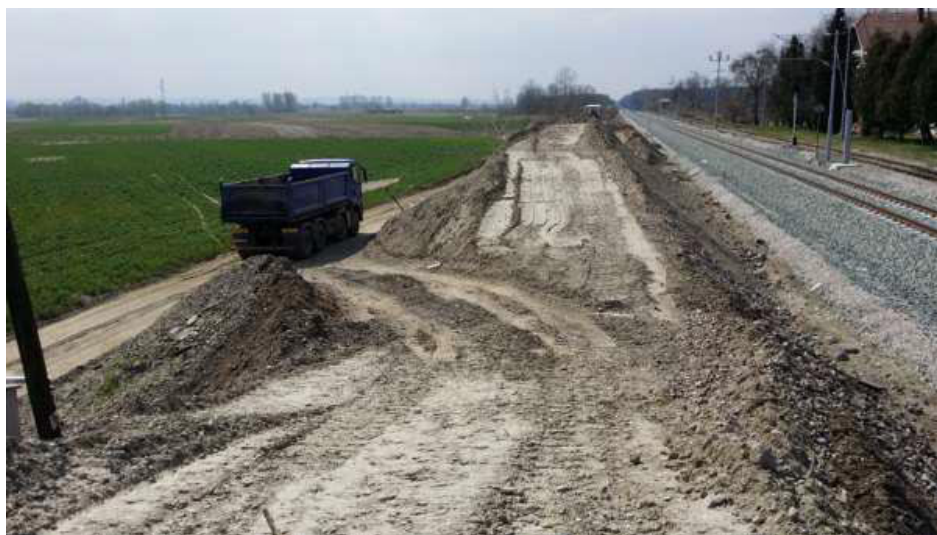
Slika 15. Izgradnja paralelnog puta uz željezničku prugu [10]
