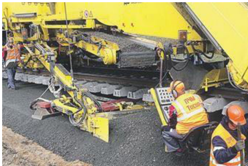
Slika 11. Ugradnja novog tamponskog sloja pomoću velikih kompaktnih ploča [9].
