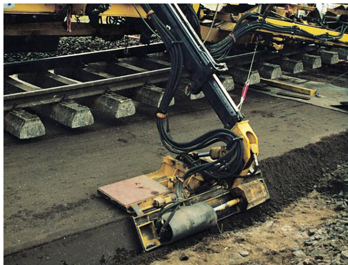
Slika 12. Završna faza uređenja novog konsolidiranog tamponskog sloja [9]
