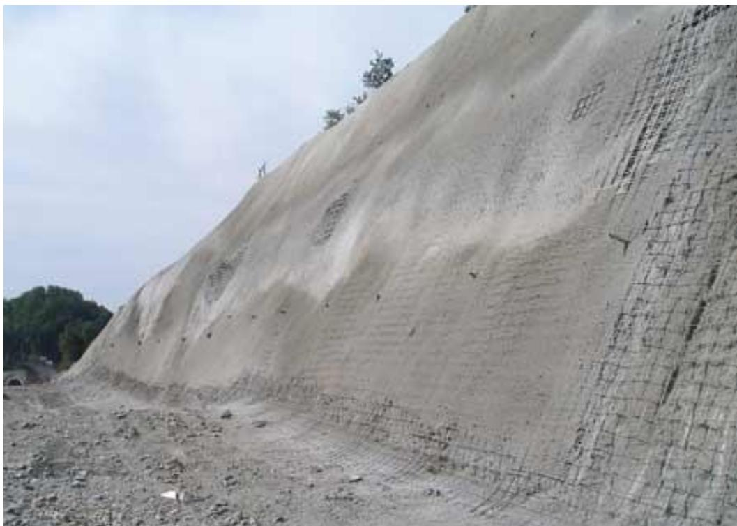
*Slika 11. Primjena mlaznog betona za zaštitu kosina*
