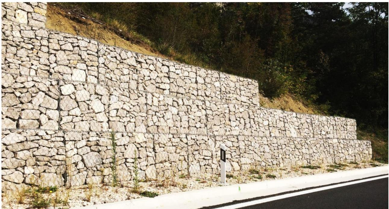
Slika 10. Potporna konstrukcija koja se koriste za bočno pridržavanje tla uslijed denivelacije terena, za osiguranje pokosa, usjeka ili zasječka te povećanja stabilnosti kod klizišta i odrona
