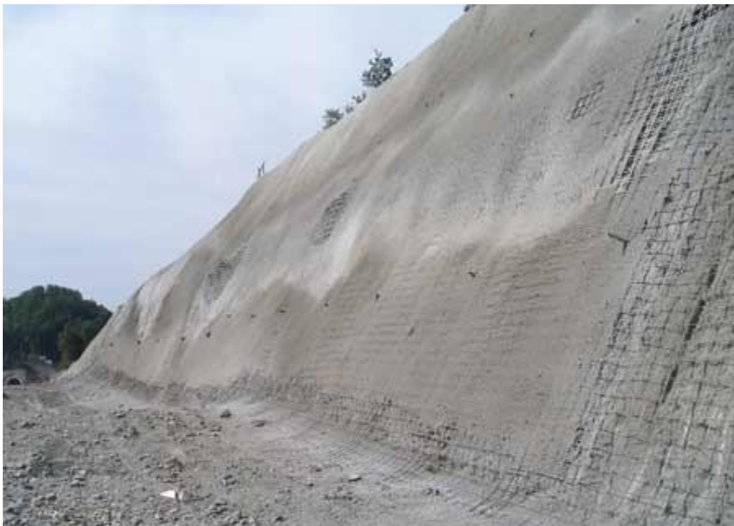
Slika 11. Primjena mlaznog betona za zaštitu kosina
