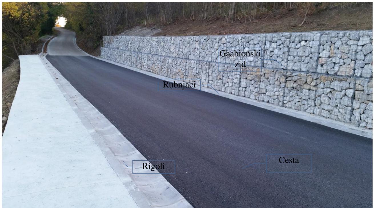
Slika 26. Izvedbeni gabionski zid ispod (preko kojeg je betonirana AB ploča) i iznad ceste
