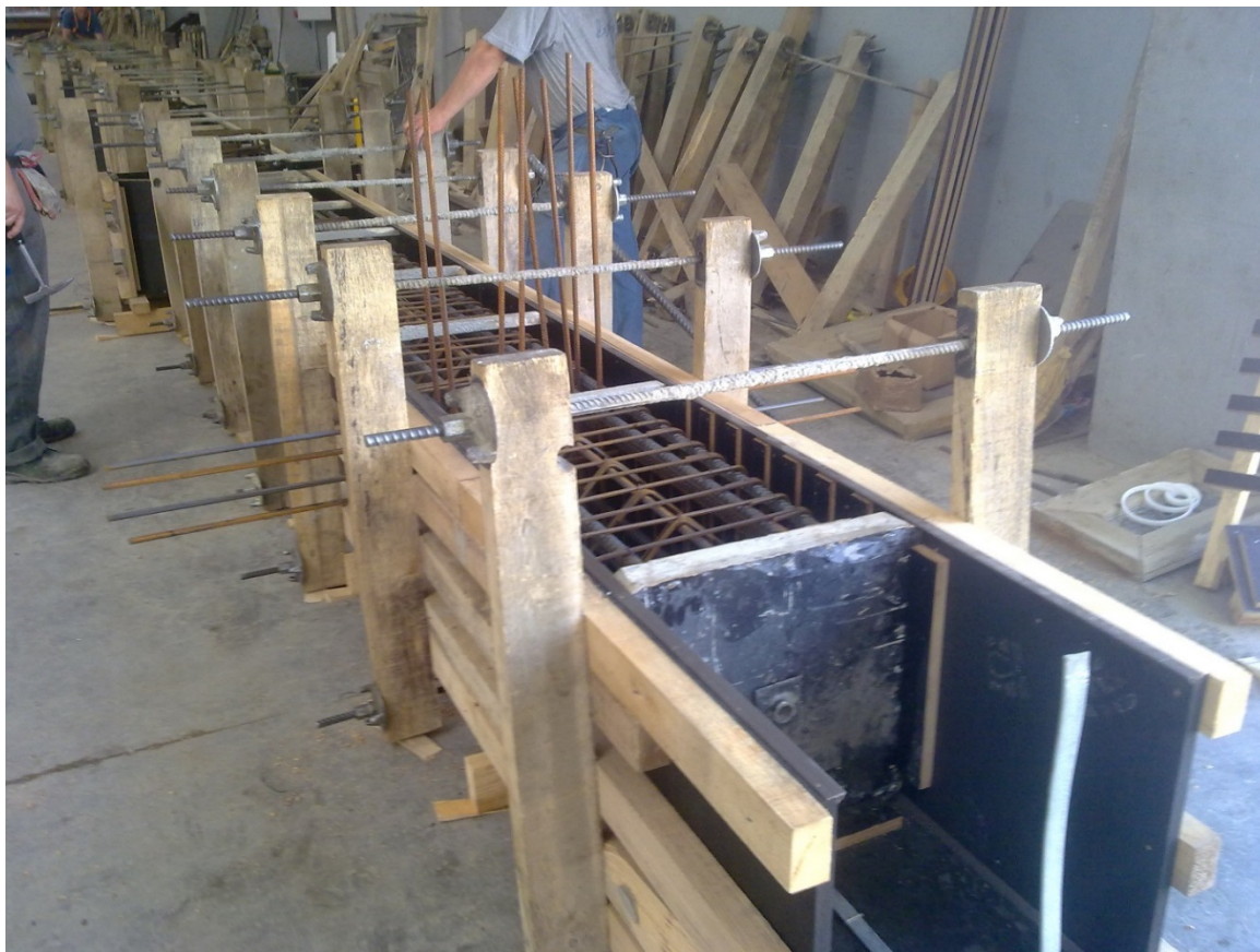
Slika 7: Provedba mjerenja i kontrole oplata u Zagorje Tehnobetonu
