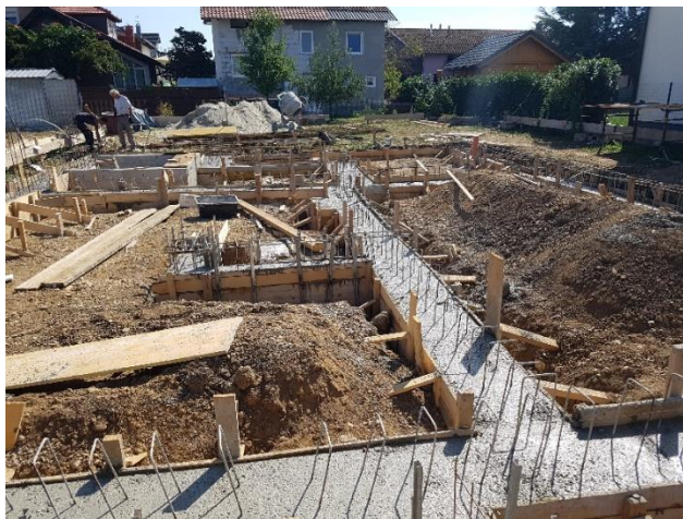
Slika 3.6. Betoniranje temelja
