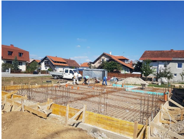
Slika 3.19. Oplata podne ploče prizemlja
