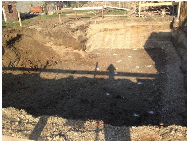
Slika 3.1. Iskop građevinske jame
