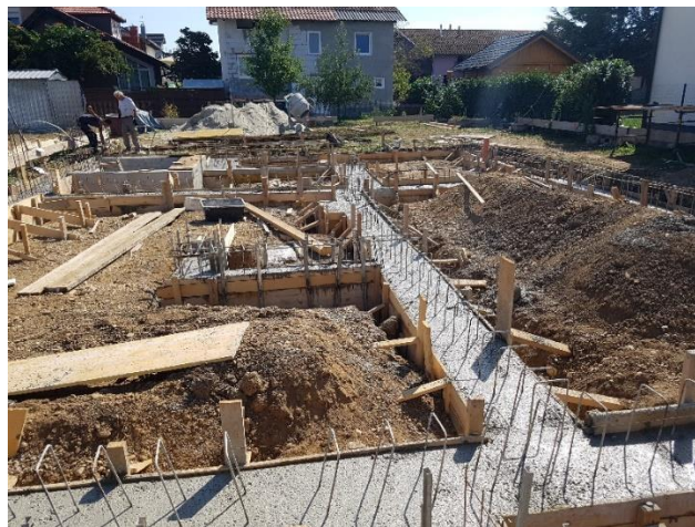
Slika 3.6. Betoniranje temelja
