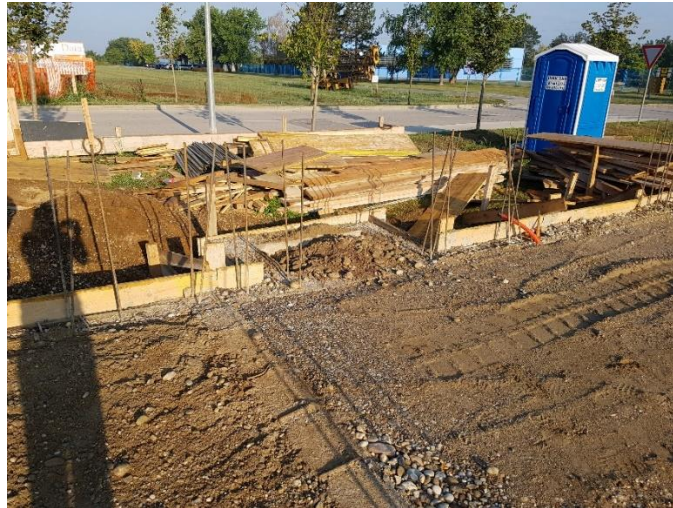
Slika 3.7. Izravnavanje podloge
