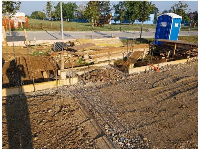
Slika 3.7. Izravnavanje podloge
