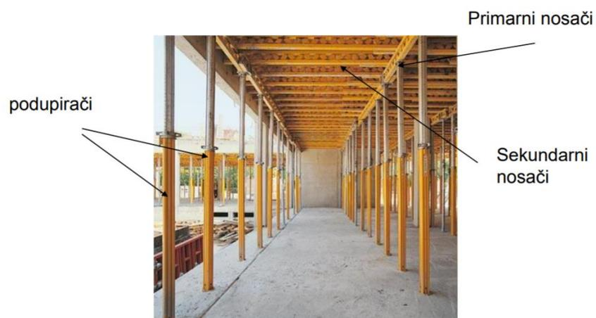
Slika 3.20. Sistem postave oplata stropne ploče
