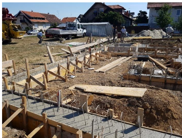
Slika 3.18. Prikaz oplata trakastih temelja
