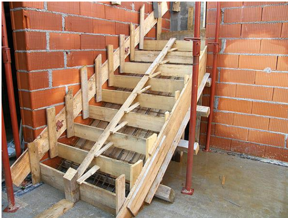
Slika 3.21. Oplata stubišta, armatura podesta
