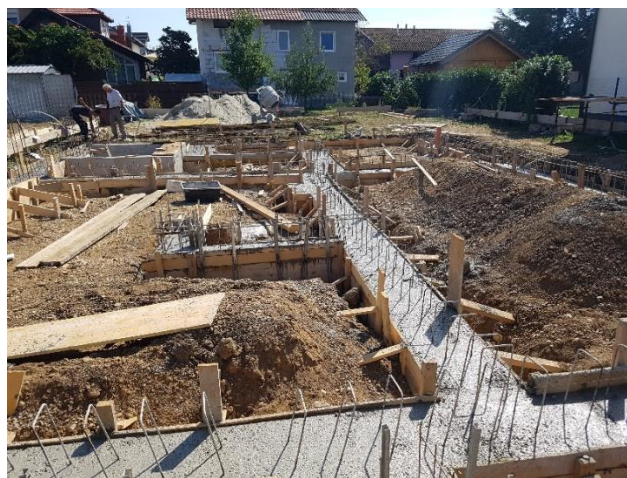
Slika 3.6. Betoniranje temelja
