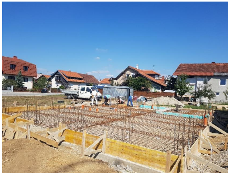
Slika 3.19. Oplata podne ploče prizemlja
