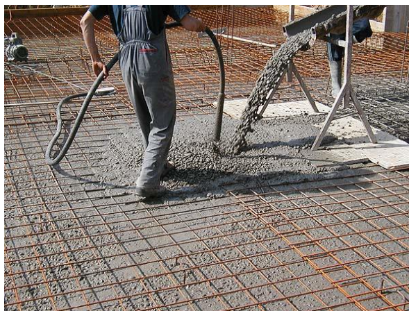
Slika 3.12. Betoniranje stropne konstrukcije
