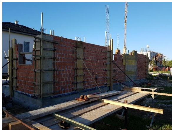
Slika 3.22. Oplata vertikalnih serklaža
