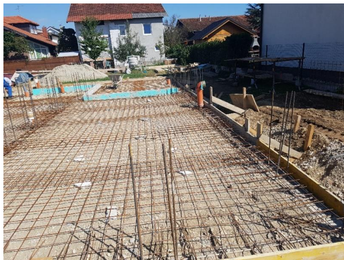
Slika 3.8. Postava armaturne mreže betonske podloge
