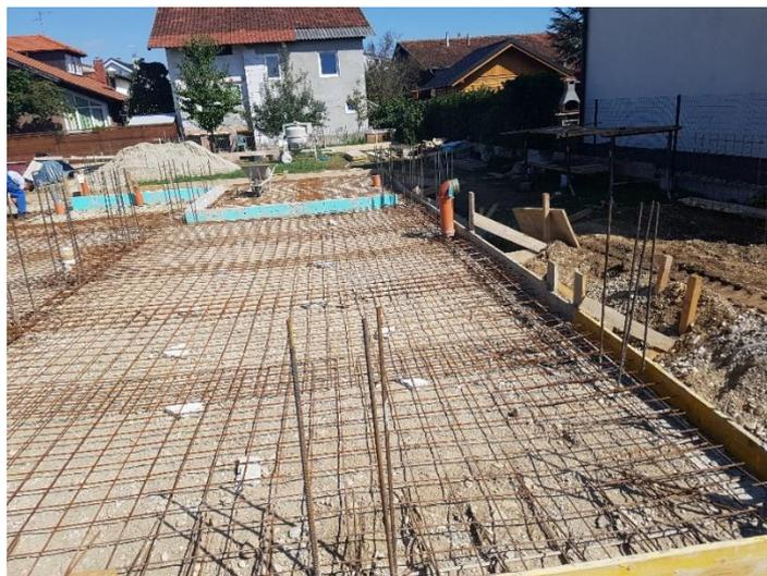
*Slika 3.8. Postava armaturne mreže betonske podloge*
