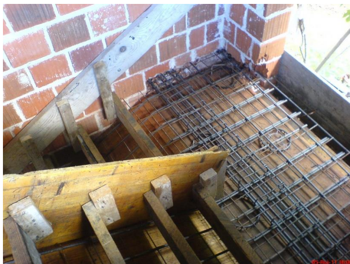
Slika 3.13. Armatura za betoniranje stubišta
