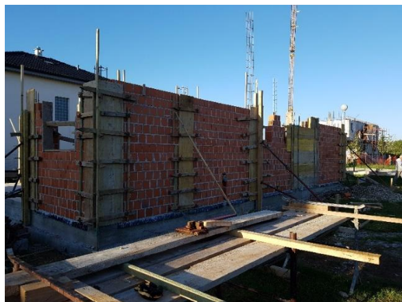
Slika 3.22. Oplata vertikalnih serklaža
