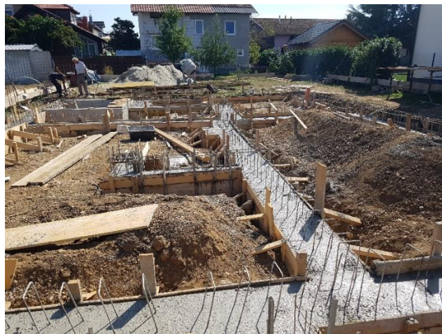
Slika 3.6. Betoniranje temelja
