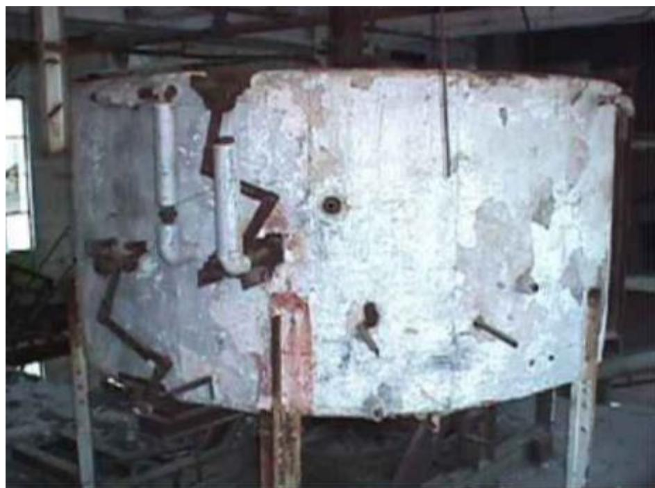
*Slika 3.7. Prikaz kotla centralnog grijanja obloženog azbestom*
