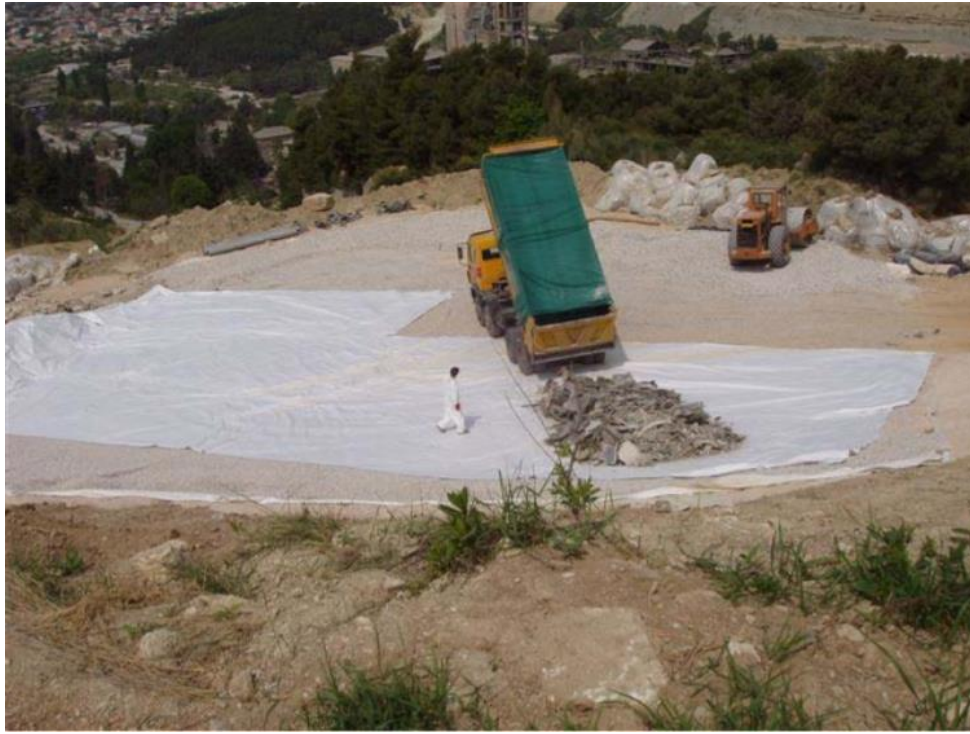
Slika 5.2. Prvi istovar azbestnog otpada na uređeno odlagalište
