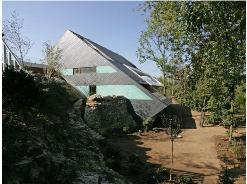
*Slika 7.6. Fasada od vlaknasto – cementnih ploča*
