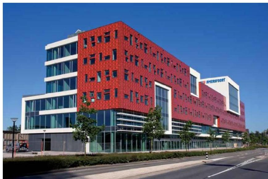
*Slika 7.8. Fasada od keramičkih pločica*
