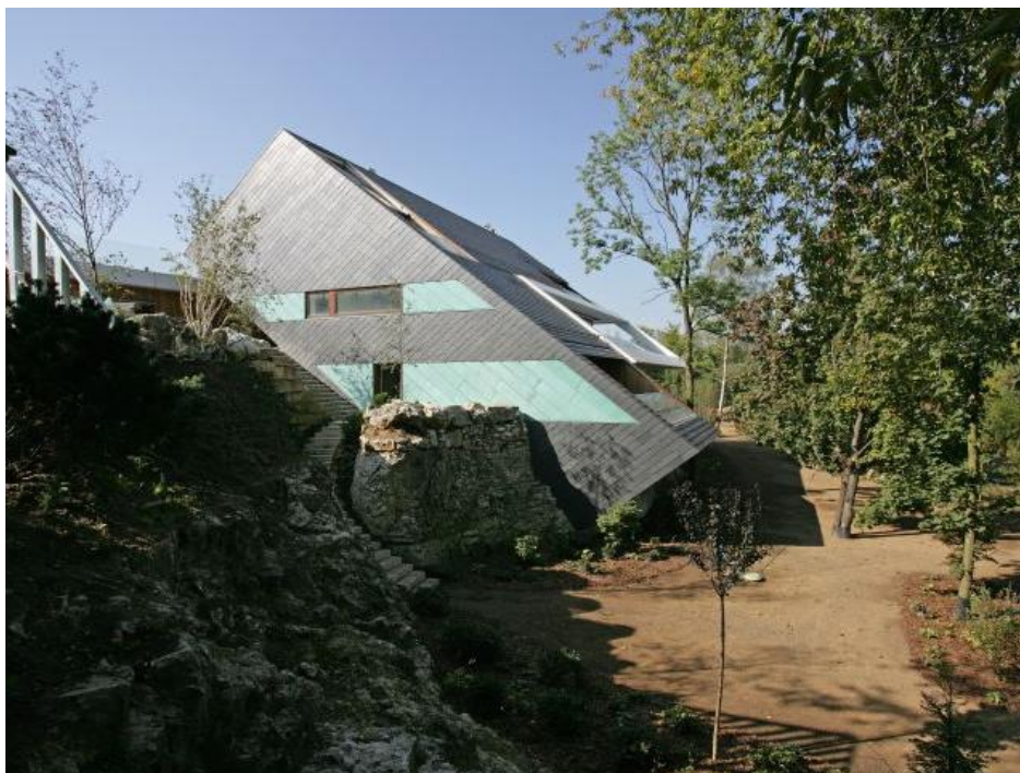
Slika 7.6. Fasada od vlaknasto – cementnih ploča
