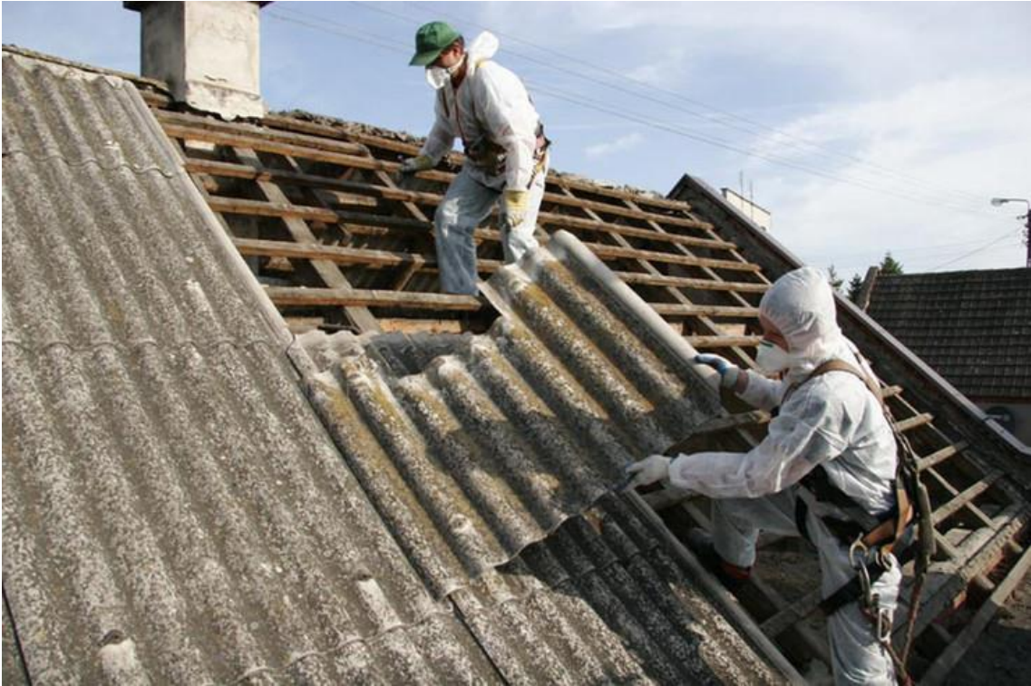
Slika 3.4. Skidanje azbestnih salonit ploča s krova
