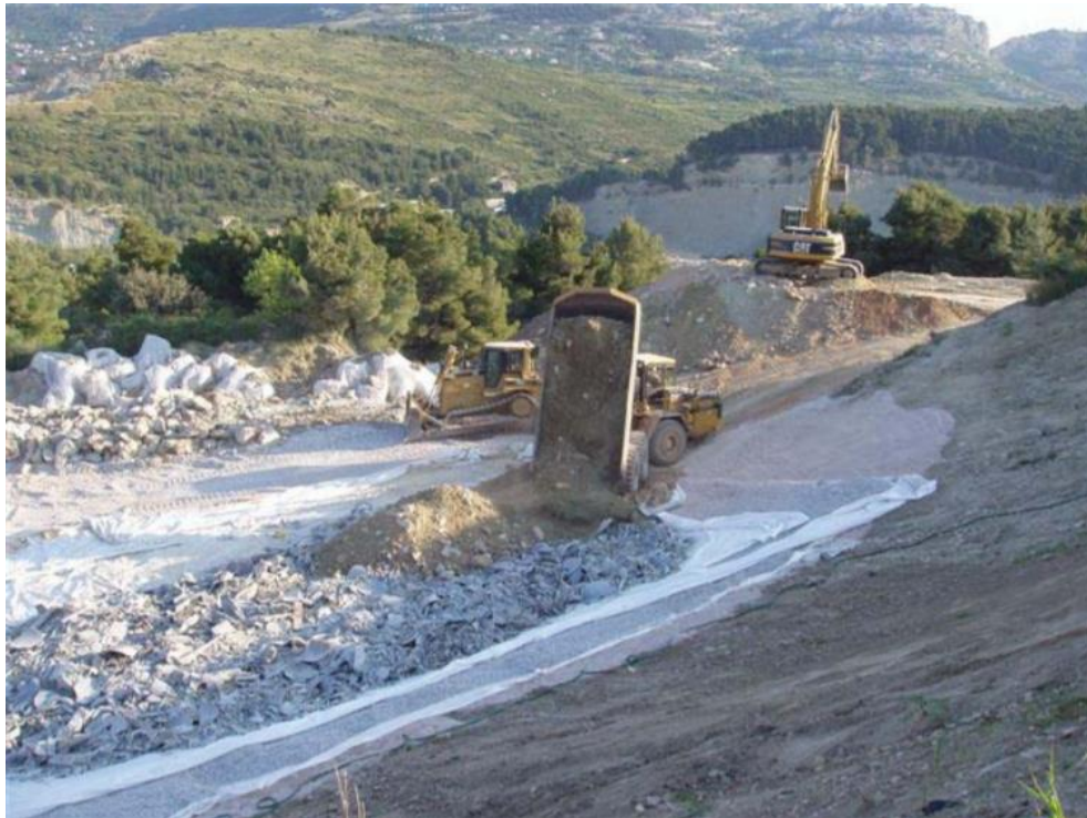
Slika 5.3. Prvi sloj zemlje preko odloženog azbestnog otpada
