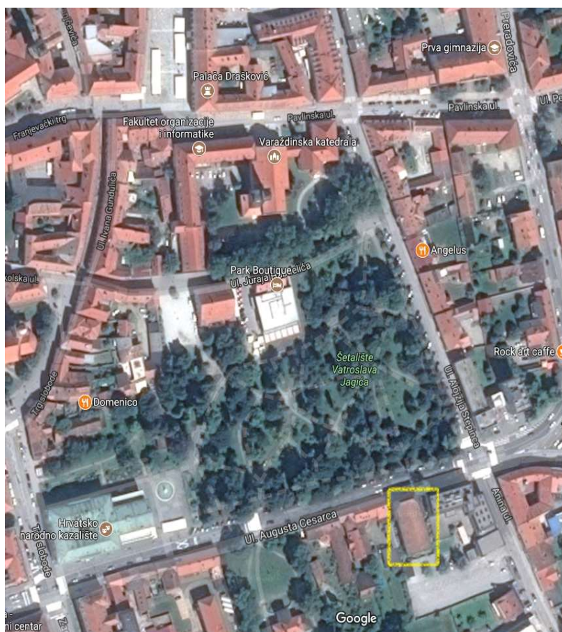
Slika 3.1. Pogled na krovšte sinagoge i na ostale navedene znamenitosti grada Varaždina. Izvor: https://www.google.hr/maps/
