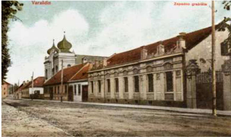
Slika 2.2. Fotografija prikazuje bočnu stranu sinagoge i dio grada pod nazivom južno grabište. Pogled sa zapada. Izvor: razglednica, Gradski muzej Varaždin
