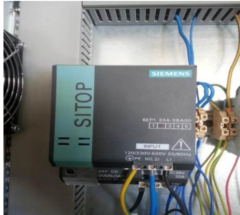
Slika 2.10. Sitop modular napajanje 24VDC [20]
