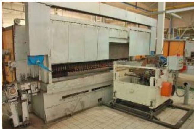
Slika 14. Hladionik za hlađenje staklenih spremnika
