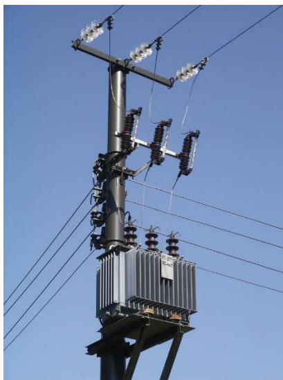
Slika 6 Stupna trafostanica
