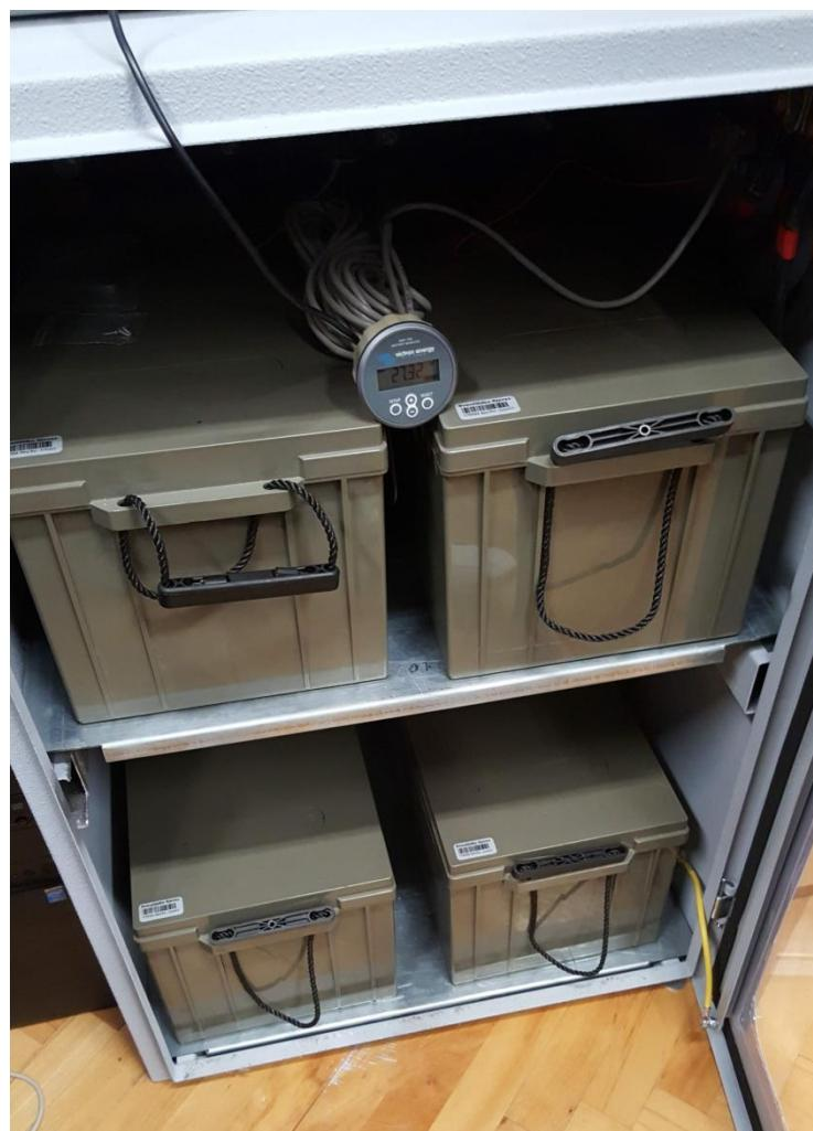
*Slika 3.4 Baterijski sustav, Baterije Victron Energy AGM 12 VDC/220Ah*
