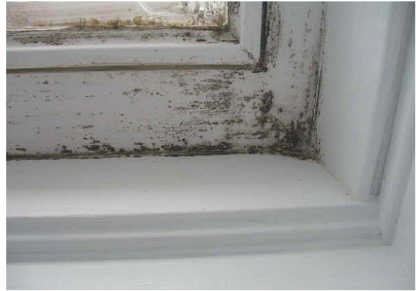
Slika 12., 13. Kondenzacija i plijesan na donjem rubu prozora
