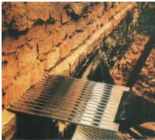
Slika 35. Postavljanje nehrđajućeg valovitog lima u rešku između redova opeka
