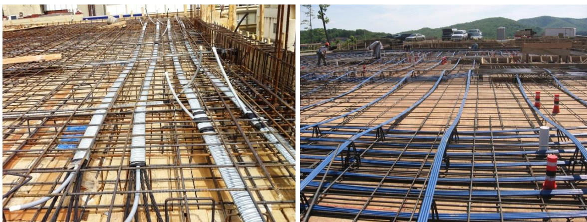
Slika 2.7 Primjer ploče s „bonded“ i „unbonded“ kabelima
