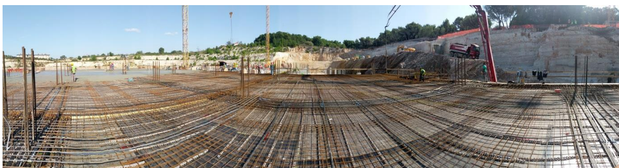
Slika 4.3 Panoramski prikaz betoniranja segmenta PT ploče
