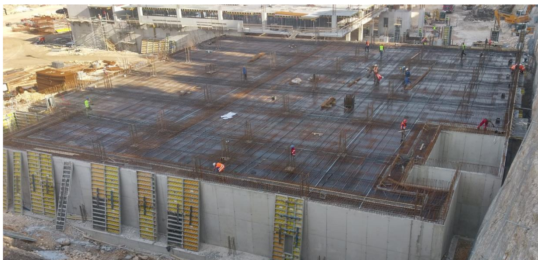
Slika 4.1 Ploča uoči betonaže, postavljena armatura i kabeli
