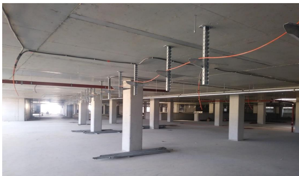
Slika 2.3 Pogled dijela ploče nakon skidanja oplata, faza postavljanja instalacija
