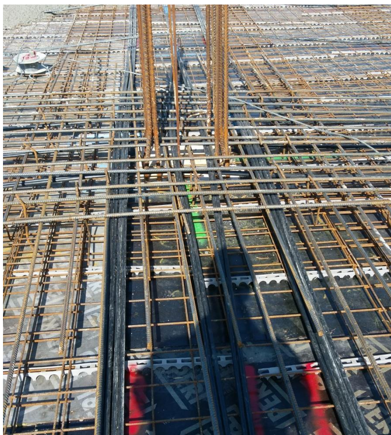
Slika 4.2 Početak betoniranja segmentne ploče. U prvom planu položaj kabela u zoni stupa.
