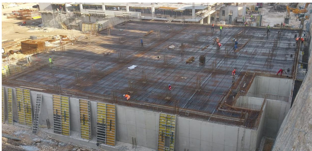
Slika 4.1 Ploča uoči betonaže, postavljena armatura i kabeli
