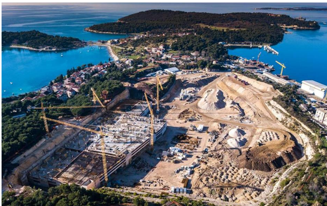
Slika 1.1 Gradilište trgovačkog centra "Max Stoja" u Puli
