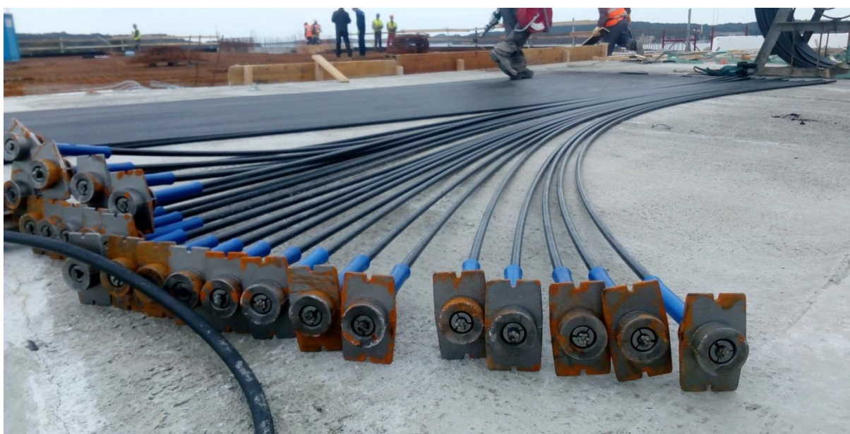
Slika 2.8 Kabeli s usidrenjima - anker pločama (gradilište „Max Stoja“)
