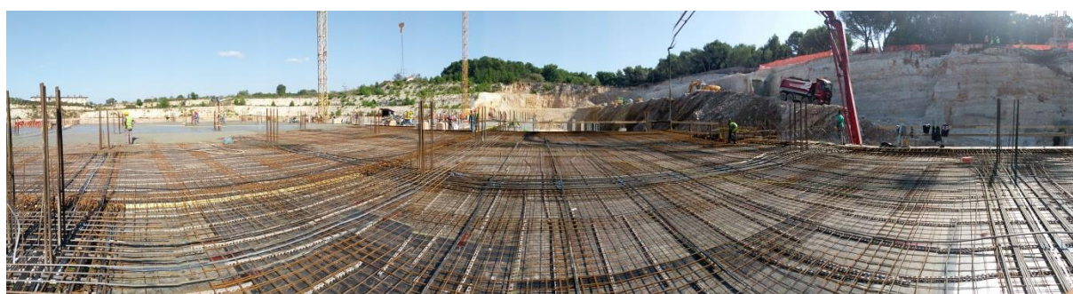
Slika 4.3 Panoramski prikaz betoniranja segmenta PT ploče
