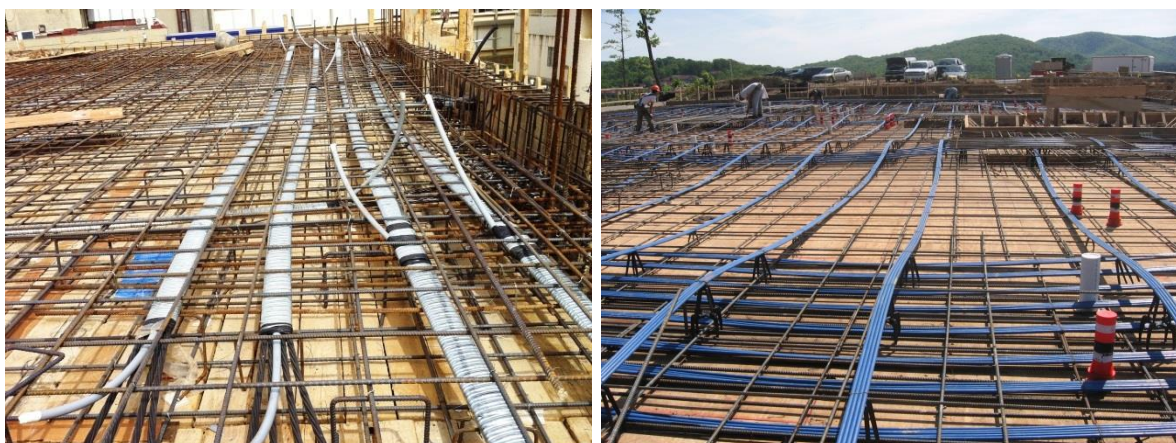
Slika 2.7 Primjer ploče s „bonded“ i „unbonded“ kabelima
