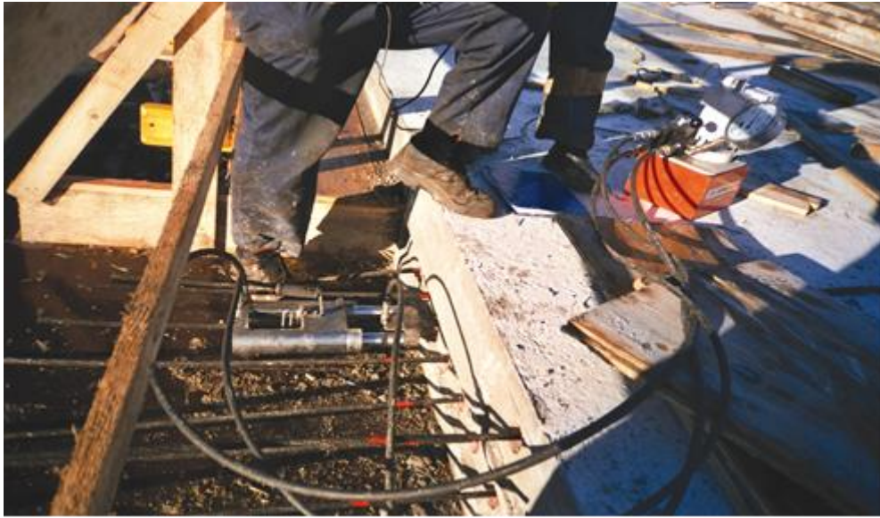
Slika 2.9 Unos sile hidrauličkom prešom na iznos od 223. KN (crvena markacija za izduženja)
