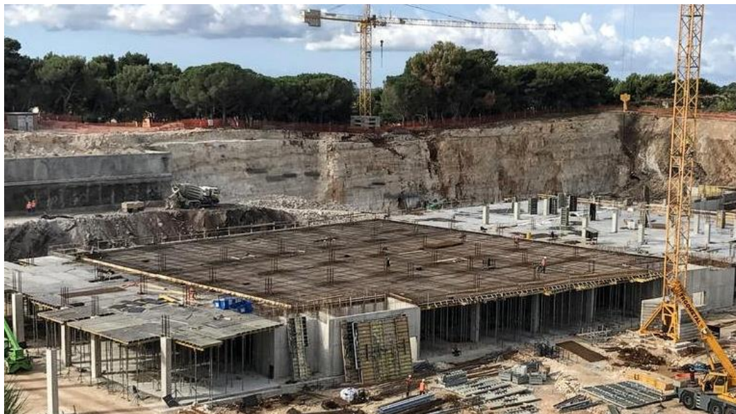
Slika 1. 1 Segment ploče uoči betonaže
