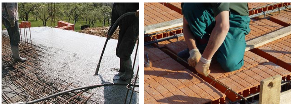
Slika 1.3 Monolitna armiranobetonska ploča i polumontažni rebrasti strop
