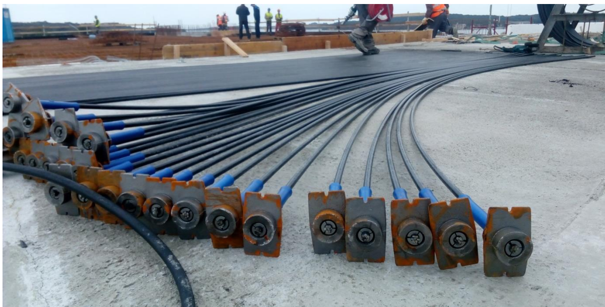
Slika 2.8 Kabeli s usidrenjima - anker pločama (gradilište „Max Stoja“)
