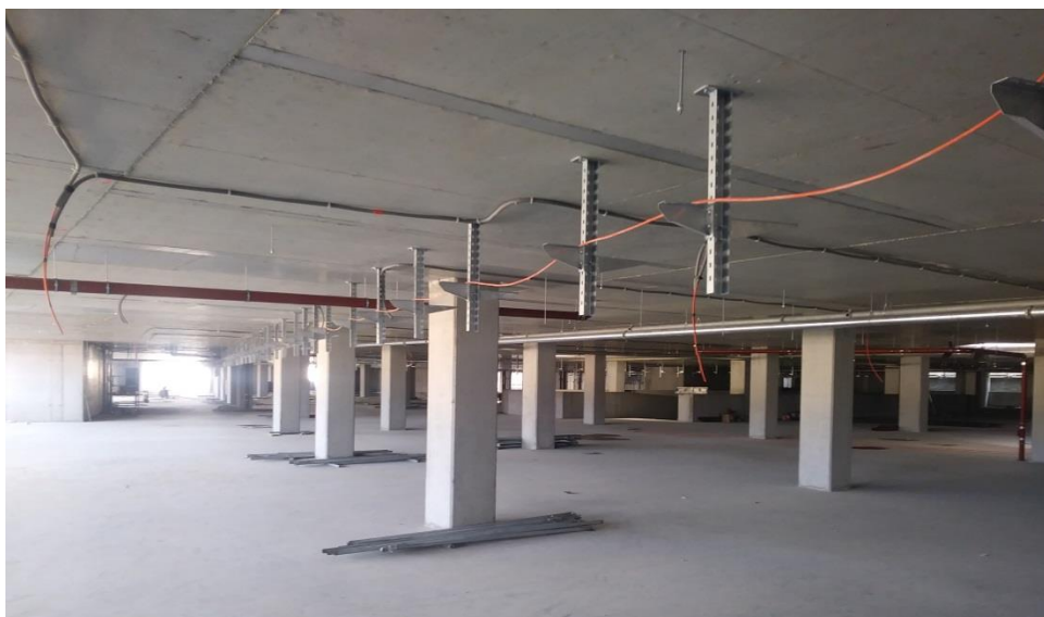
Slika 2.3 Pogled dijela ploče nakon skidanja oplata, faza postavljanja instalacija
