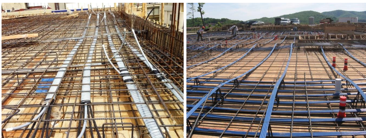
Slika 2.7 Primjer ploče s „bonded“ i „unbonded“ kabelima
