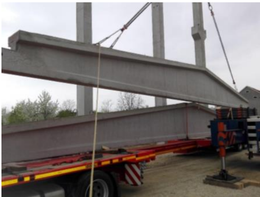
Slika 32. Doprema glavnog krovnog nosača te montiranje istog
