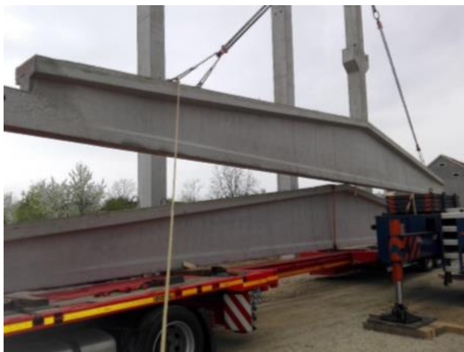
Slika 32. Doprema glavnog krovnog nosača te montiranje istog
