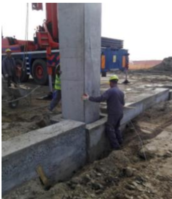
Slika 26. Postavljanje stupa u temeljnu čašu
