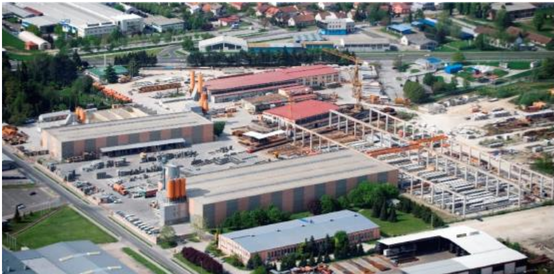
Slika 4. Stacionarna tvornica predgotovljenih betonskih elemenata
