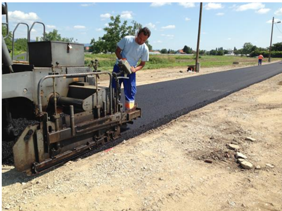
Slika 5. Strojna ugradnja BNHS 16 (AC 16-NH) – Zagreb Borovje (izvor: baza podataka Zagrebačke ceste)
