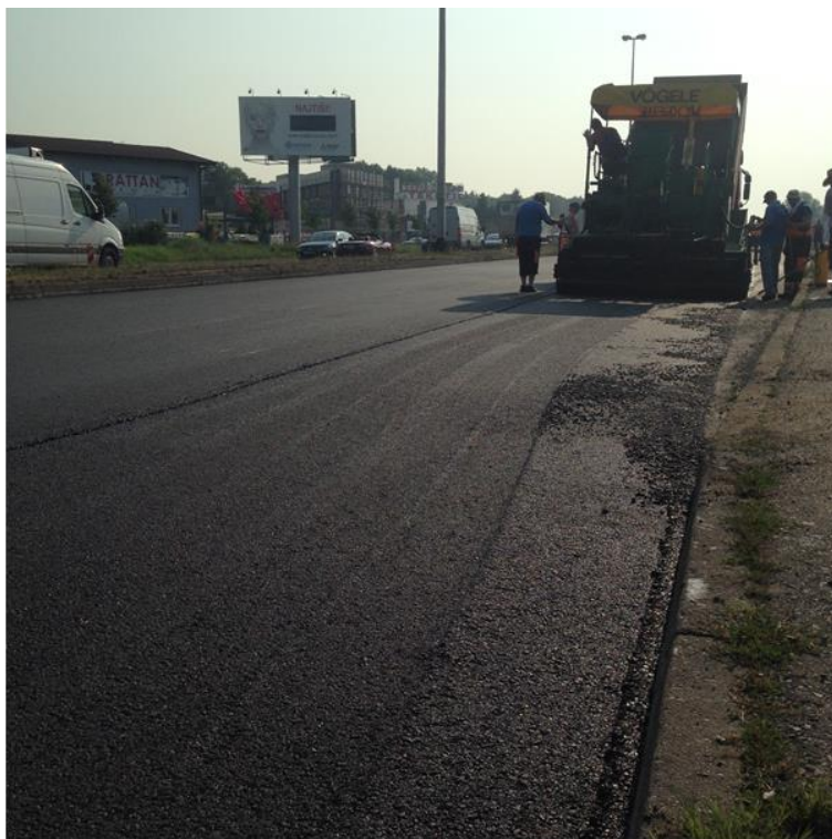
Slika 8. Strojna ugradnja asfalt betona (AC-16) – Zagreb Žitnjak(izvor: baza podataka Zagrebačke ceste)
