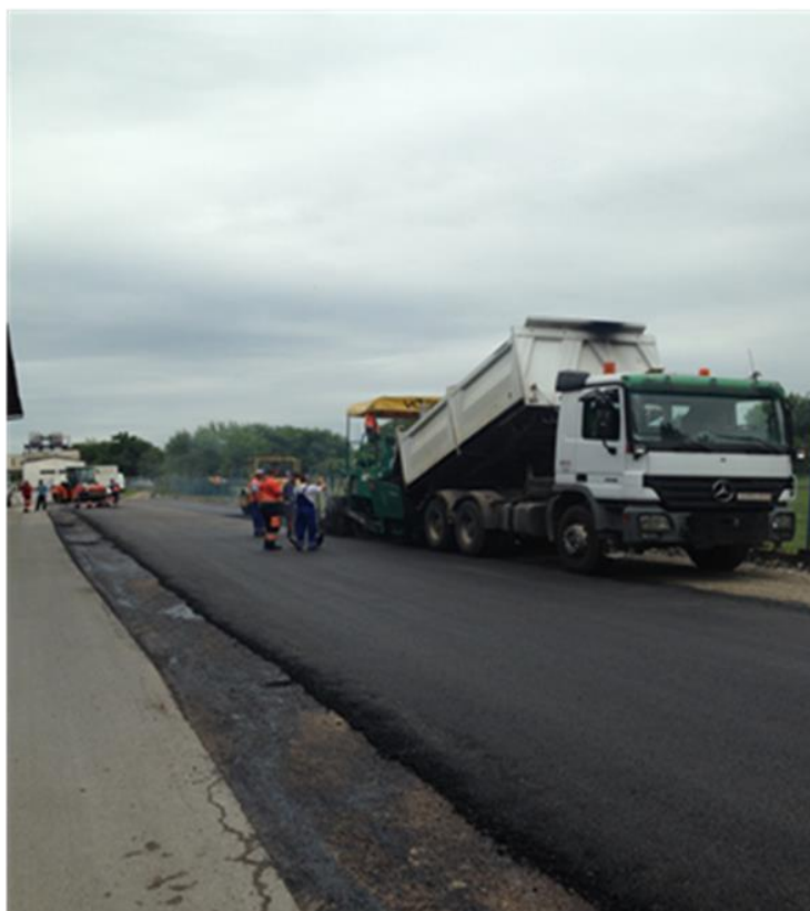
Slika 4. Strojna ugradnjaasfaltne mješavine BNS 22 (AC 22-N) – Zagreb Žitnjak(izvor: baza podataka Zagrebačke ceste)
