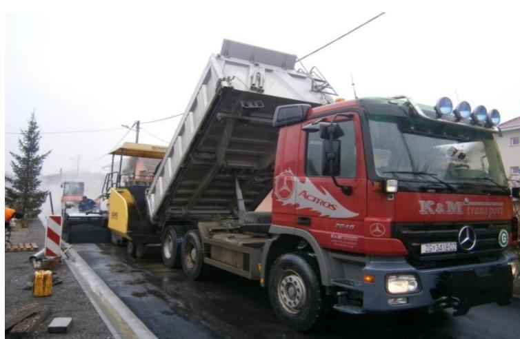
Slika 18. Strojna ugradnja reciklirane asfaltne mase finišerom (izvor: baza podataka Zagrebačke ceste)
