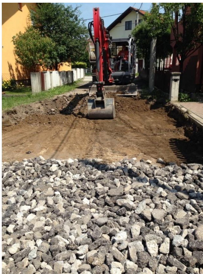
Slika 14. Strojni iskop dotrajalog makadamskog kolnika (izvor: baza podataka Zagrebačke ceste)
