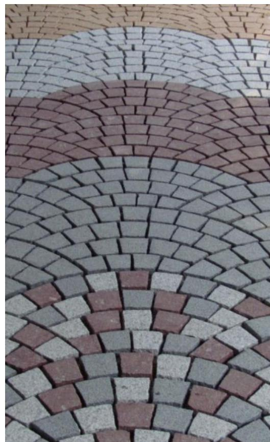
Slika 13. Shematsko postavljanje kocke u svrhu dobivanja vizualnog efekta
