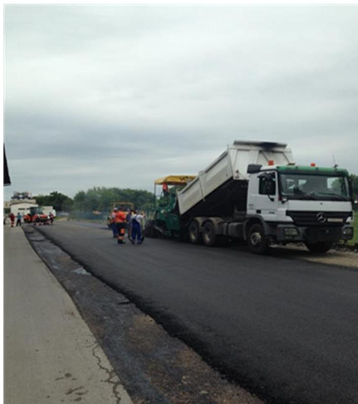
Slika 4. Strojna ugradnja asfaltne mješavine BNS 22 (AC 22-N) – Zagreb
