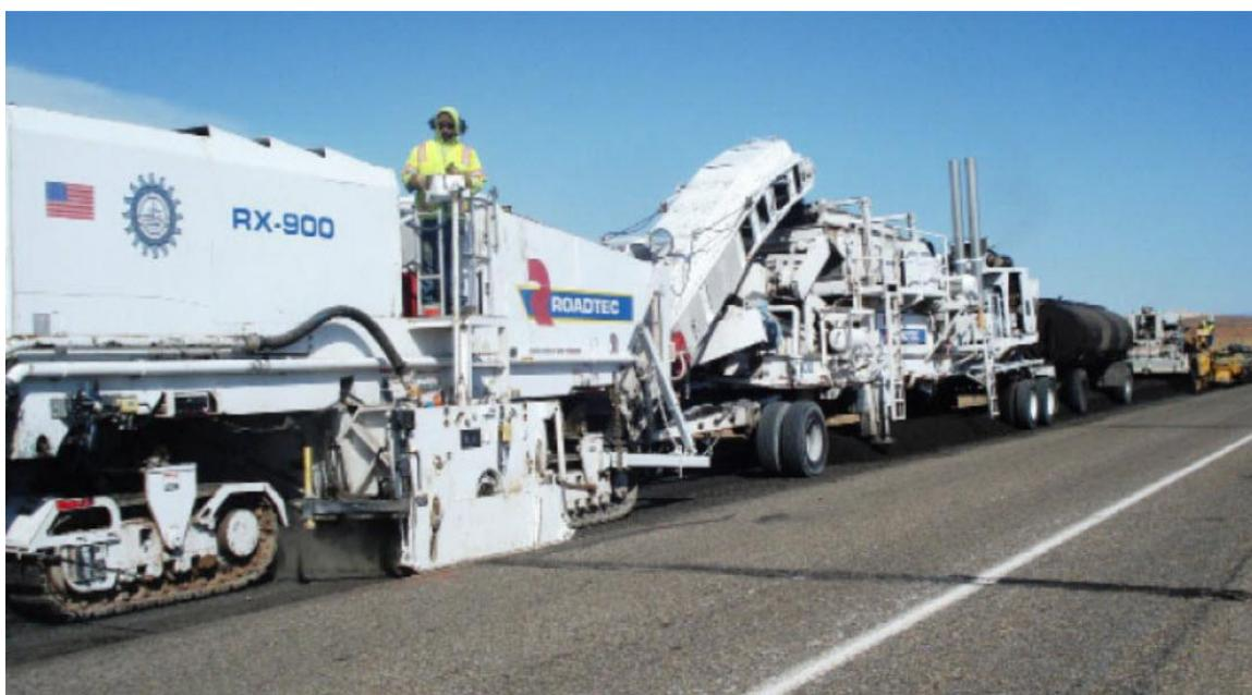
Slika 20. Kombinirani stroj za izmjenu i ugradnju asfaltne mješavine
