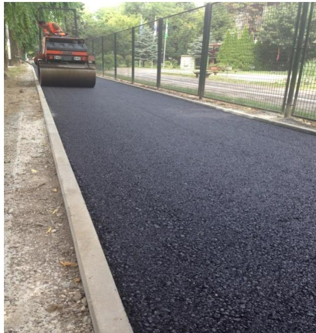
Slika 19. Ugradnja i valjanje reciklirane asfaltne mase
