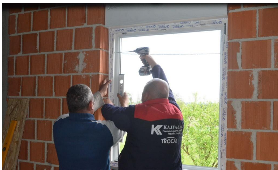
Slika 17. Ugradnja PVC prozora
