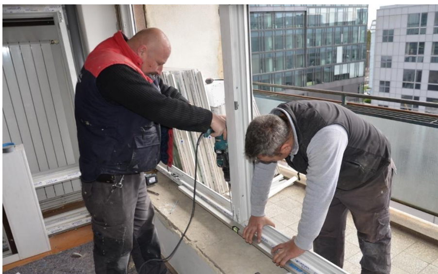
Slika 18. Montaža PVC balkonskih prozora i vrata
