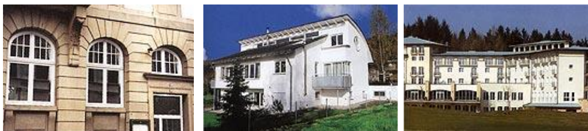
Slika 11. Primjeri ugrađenih prozorskih sustava na obiteljskim objektima
