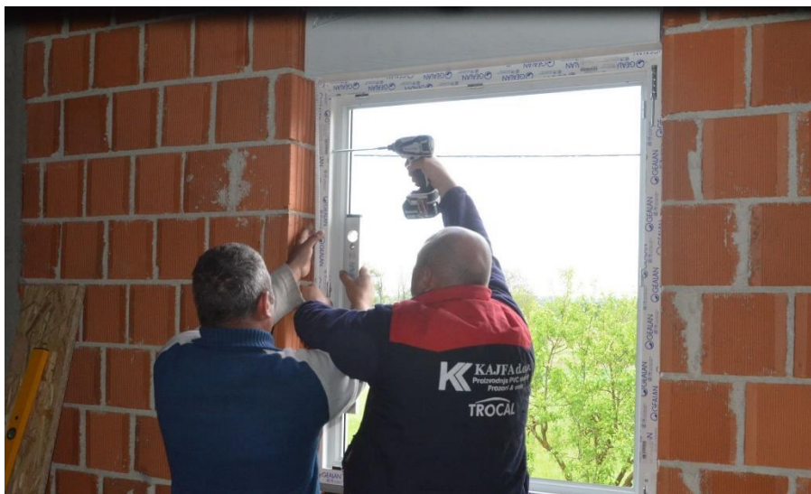
Slika 17. Ugradnja PVC prozora
