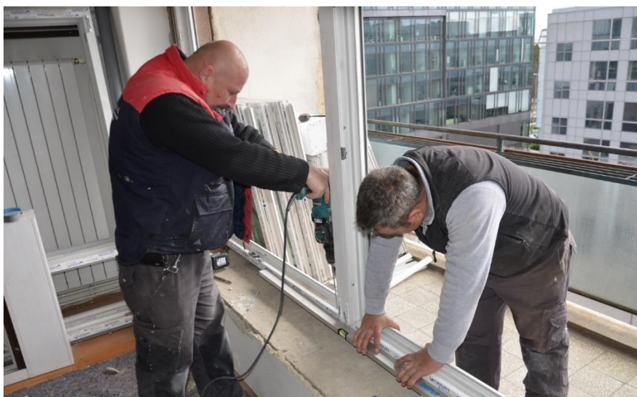
Slika 18. Montaža PVC balkonskih prozora i vrata
