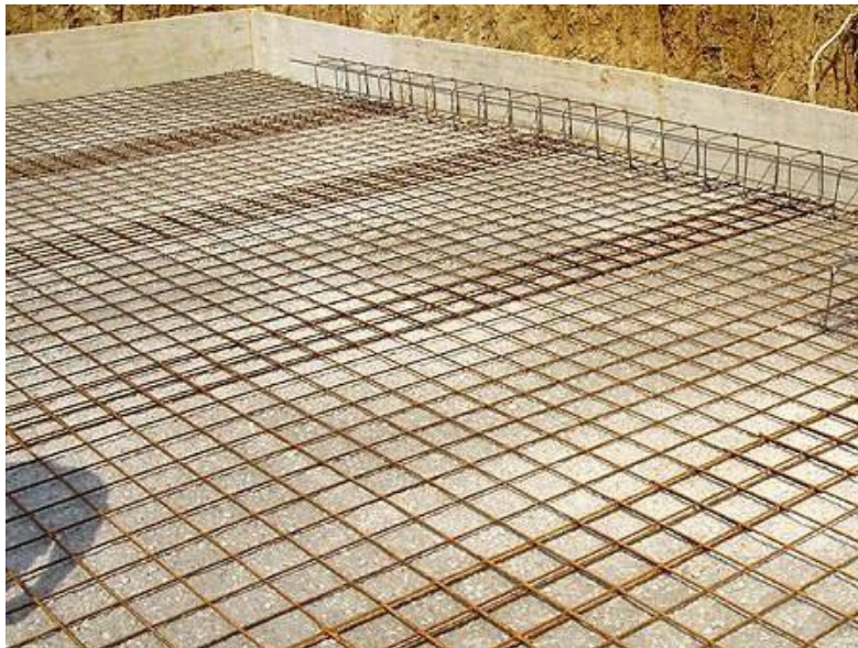
Slika 4.6. Priprema za betoniranje temeljne ploče
