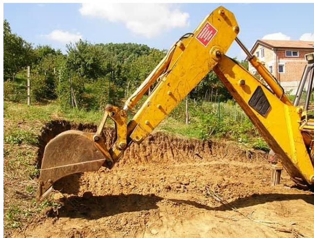
Slika 4.1. Široki iskop terena
