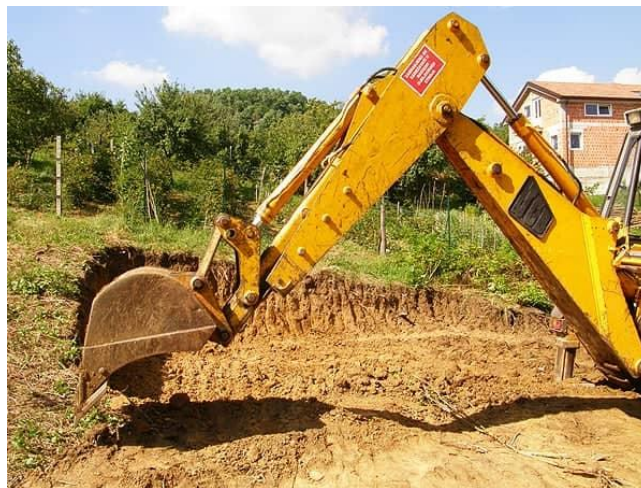
Slika 4.1. Široki iskop terena
