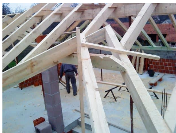
Slika 4.3. Izrada krovne konstrukcije
