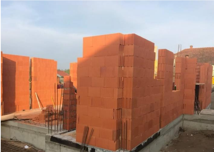
Slika 4.7. Zidanje zidova prizemlja
