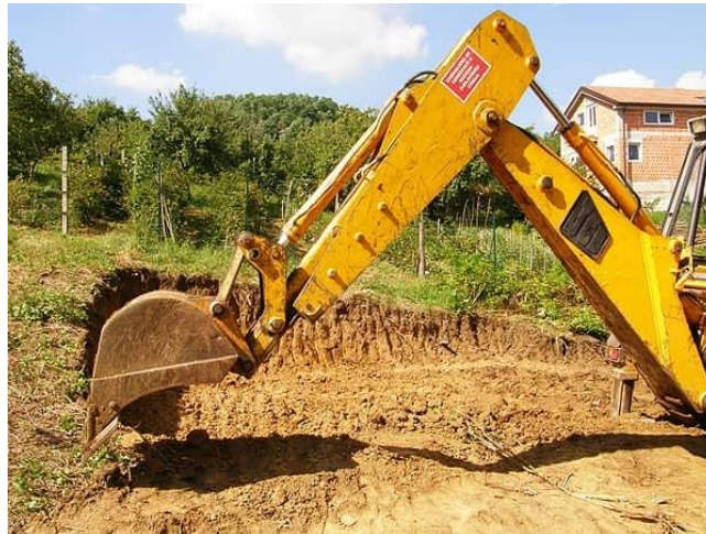
Slika 4.1. Široki iskop terena
