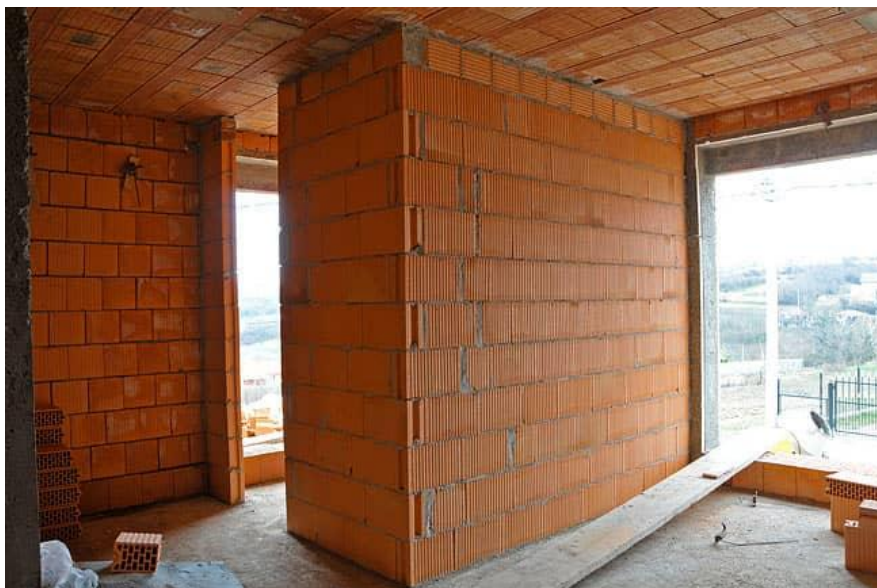
Slika 4.8. Zidanje pregradnih zidova
