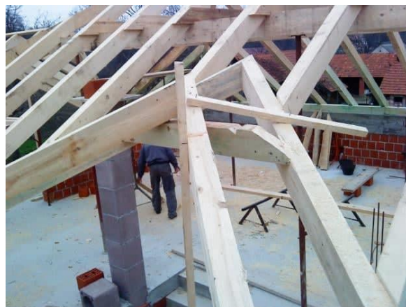
Slika 4.3. Izrada krovne konstrukcije
