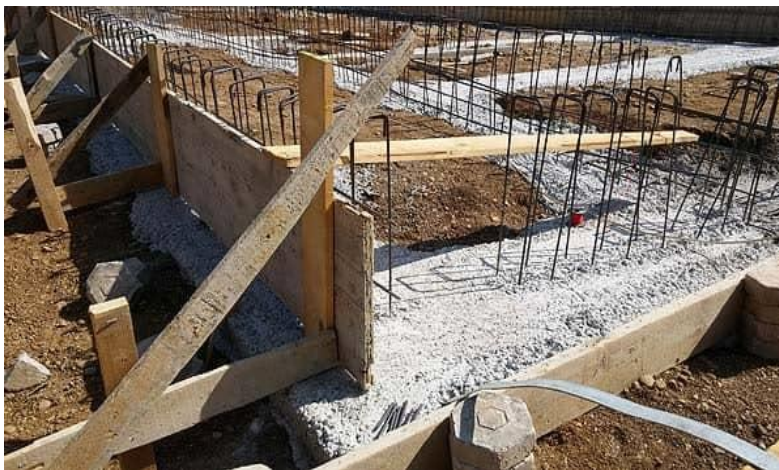
Slika 4.5. Betonirani trakasti temelji
