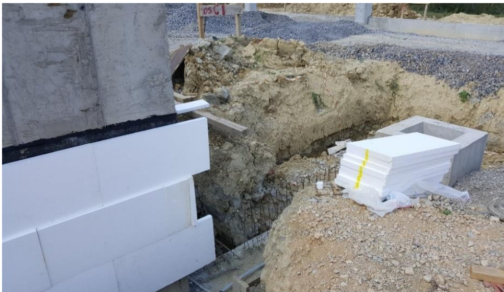
Slika 3.9. Horizontalna izrada toplinske izolacije zidova i temelja
