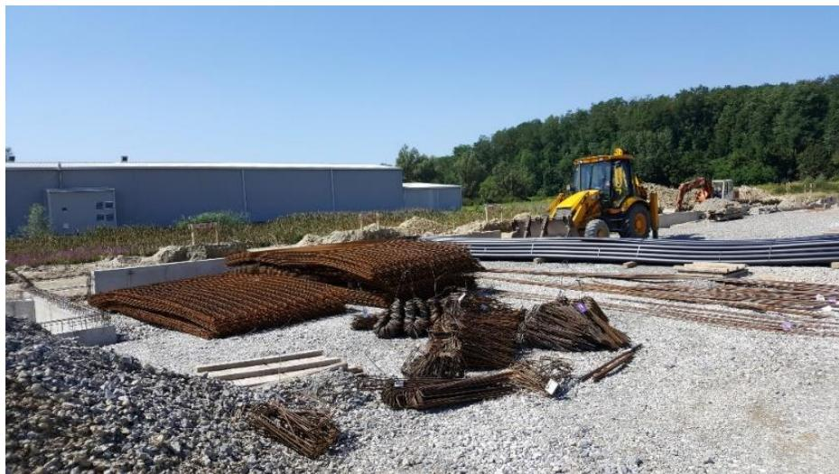
Slika 3.4. Dopremljena armatura iz armiračkog pogona
