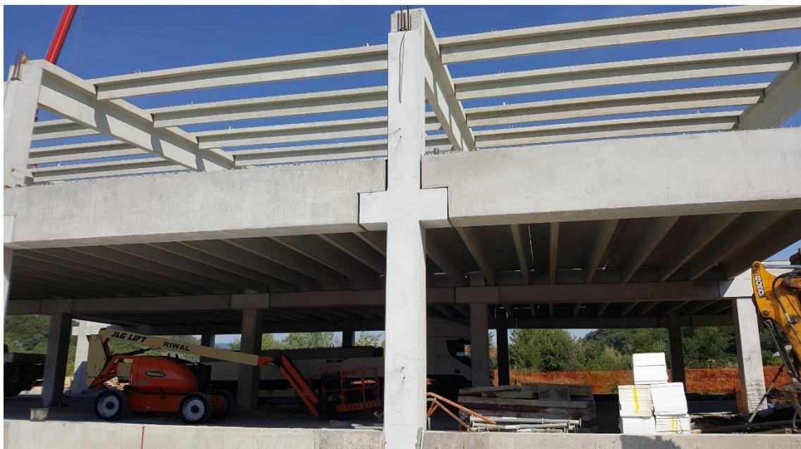
Slika 3.8. Montirani predgotovljeni elementi zgrade
