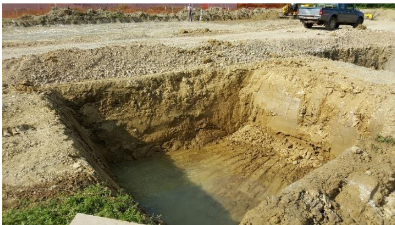
Slika 3.2. Strojni široki iskop temeljnih stopa
