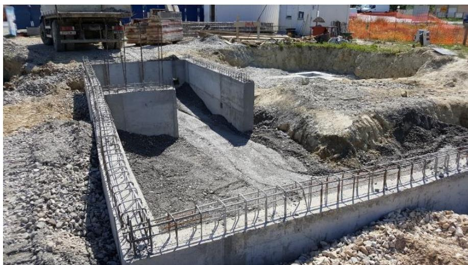
Slika 3.5. Betonirani trakasti temelj s ugrađenom armaturom
