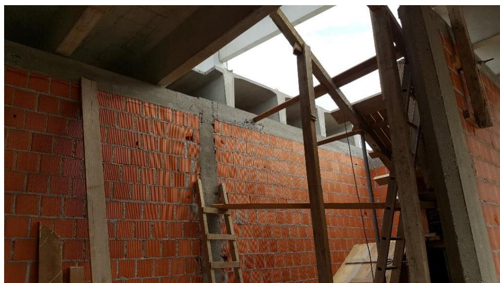
*Slika 3.7. Unutarnji pregradni zidovi izvedeni šupljom blok opekom*
