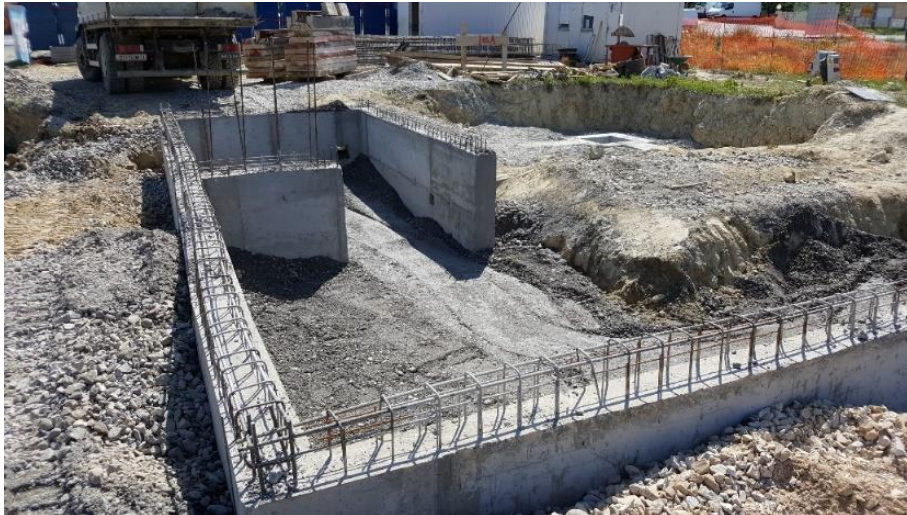
Slika 3.5. Betonirani trakasti temelj s ugrađenom armaturom
