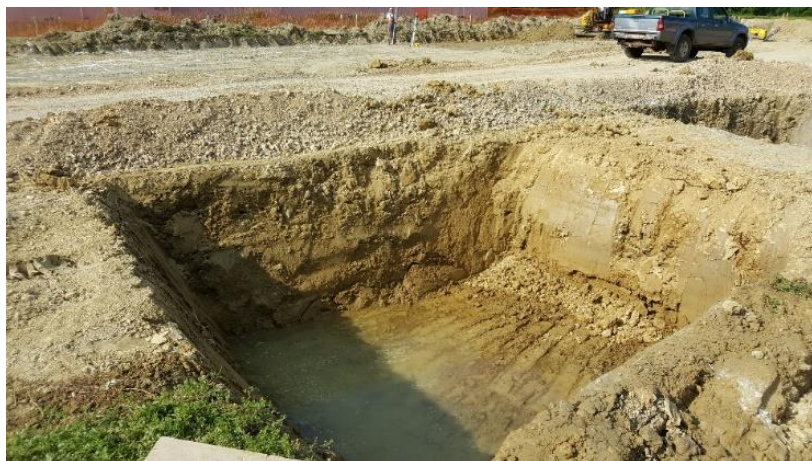
Slika 3.2. Strojni široki iskop temeljnih stopa
