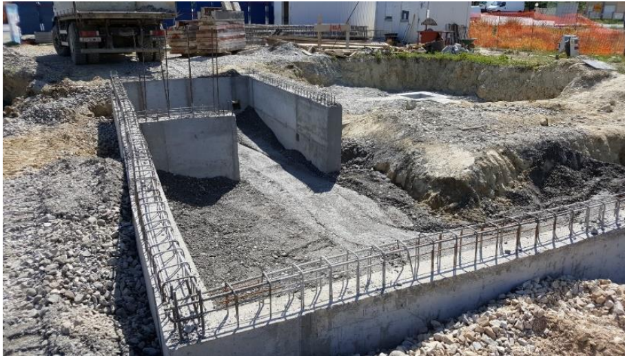
Slika 3.5. Betonirani trakasti temelj s ugrađenom armaturom
