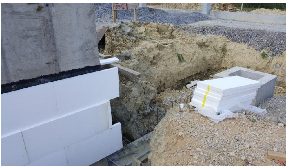
Slika 3.9. Horizontalna izrada toplinske izolacije zidova i temelja
