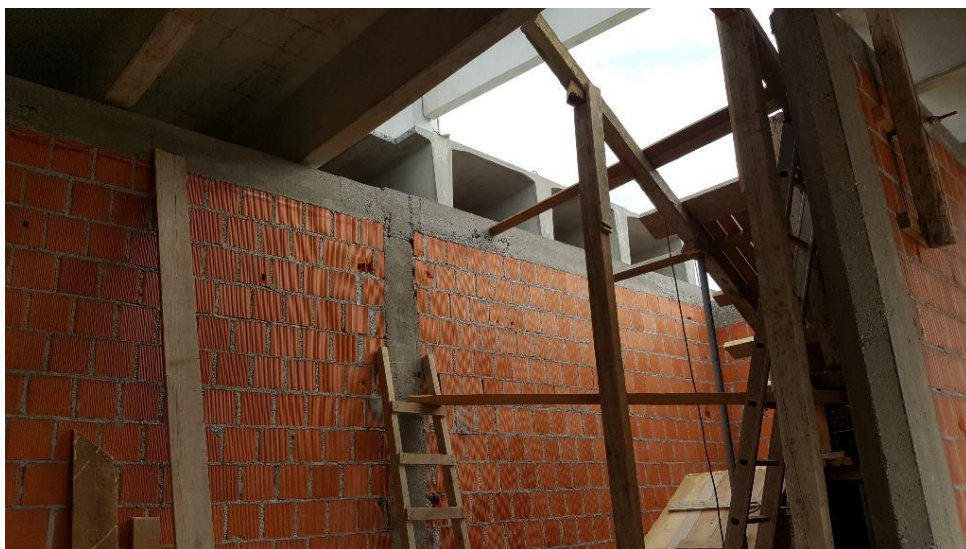
Slika 3.7. Unutarnji pregradni zidovi izvedeni šupljom blok opekom
