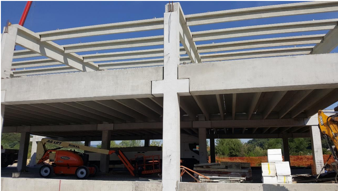
Slika 3.8. Montirani predgotovljeni elementi zgrade
