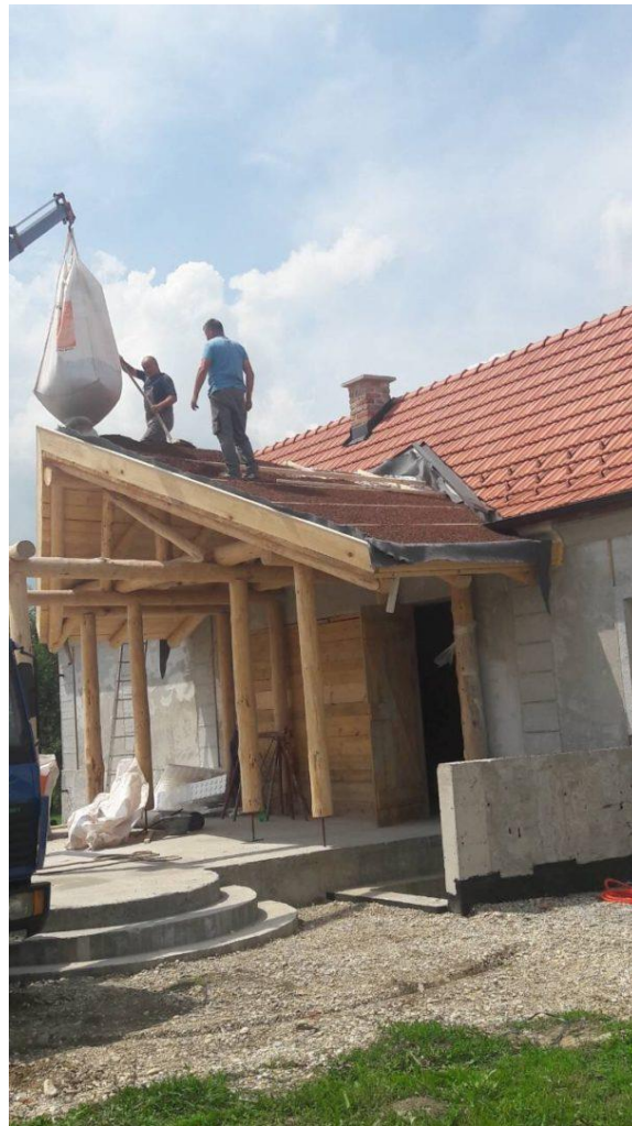
Slika 5.3. Izvedba kosog zelenog krova u Murskom Središću
