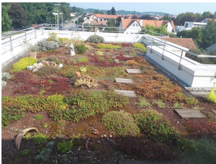
Slika 5.1. Ekstenzivan zeleni krov izveden 2007. godine, Čakovec, ul. I. G. Kovačića
