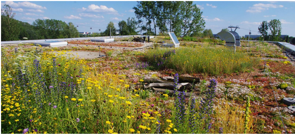
Slika 3.3. Izgled ekstenzivnog zelenog krova
