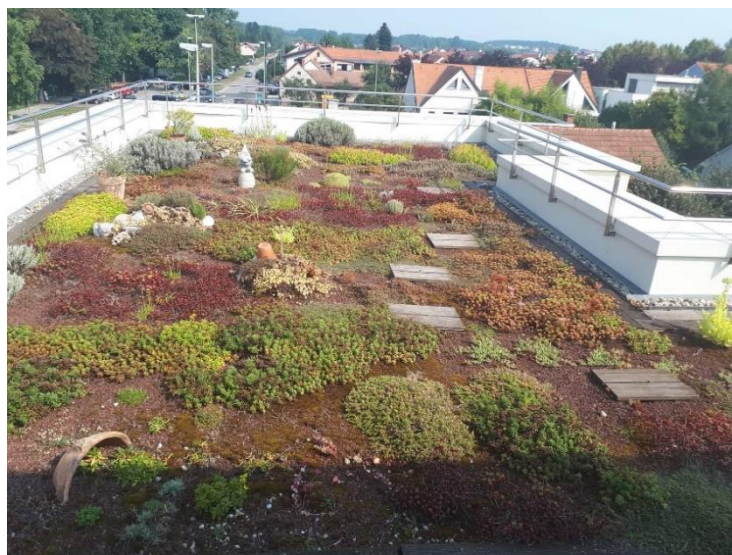
Slika 5.1. Ekstenzivan zeleni krov izveden 2007. godine, Čakovec, ul. I. G. Kovačića
