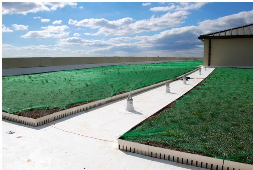
Slika 3.9. Odvajanje dijelova zelenog krova rubnim profilima
