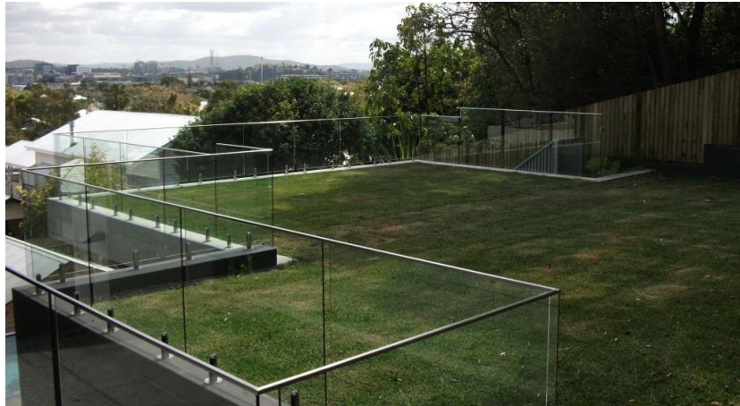
Slika 3.10. Staklena ograda na zelenom krovu
