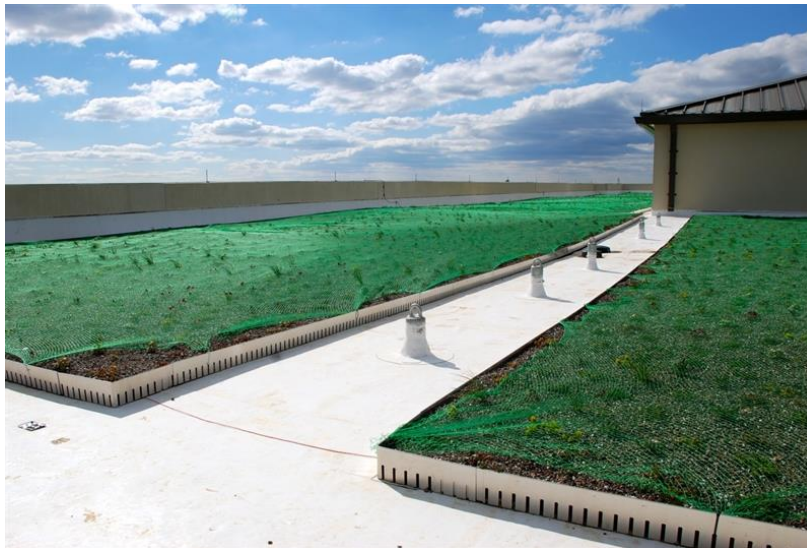
Slika 3.9. Odvajanje dijelova zelenog krova rubnim profilima
