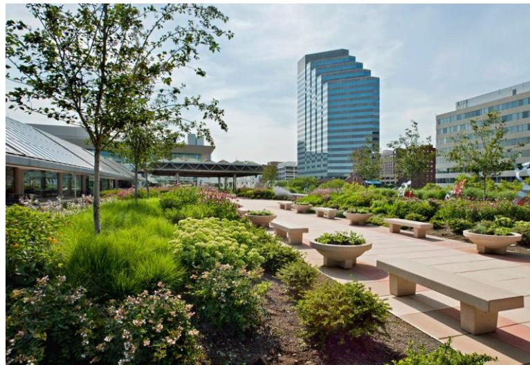
*Slika 3.5. Izgled intenzivnog zelenog krova*
