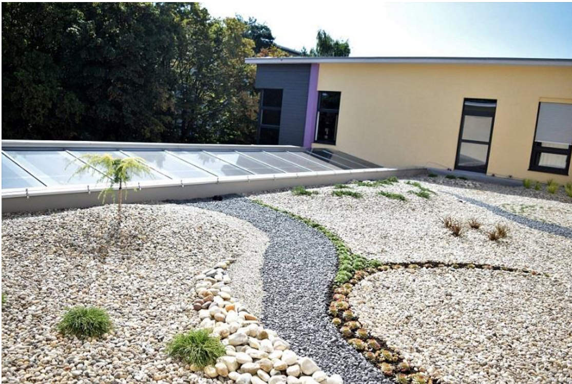
Slika 5.4. Zeleni krov izveden na gimnaziji Josipa Slavenskog u Čakovcu
