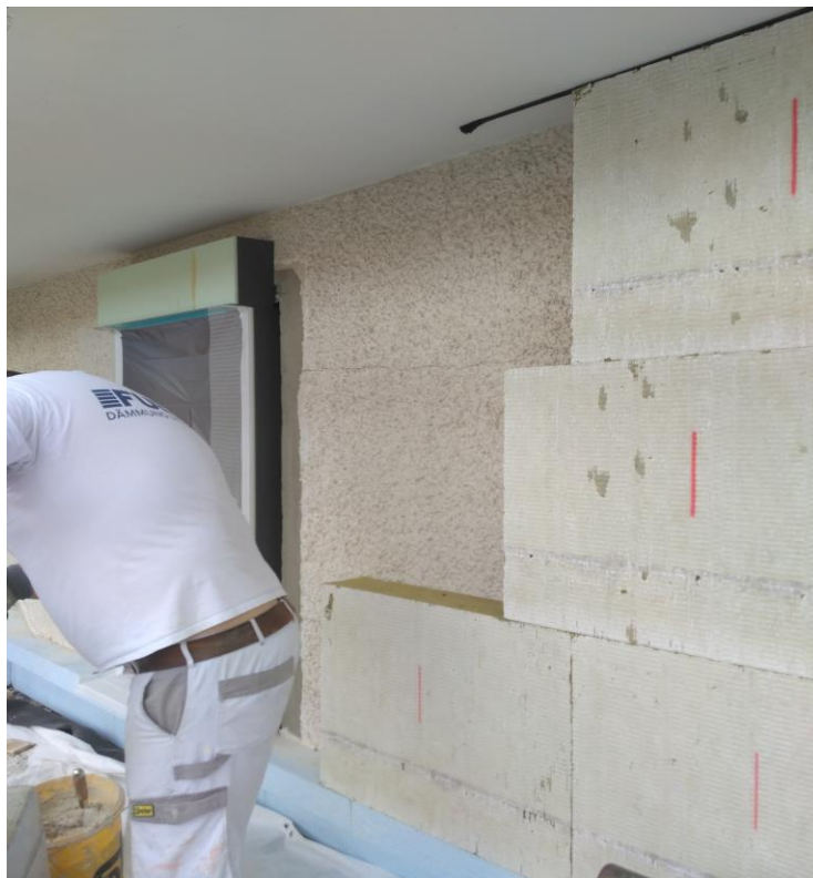
Slika 17: Postavljanje fasade od kamene vune
