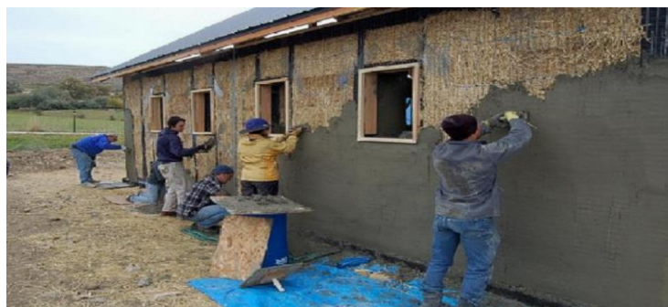
Slika 20: Žbukanje kuće od slame
