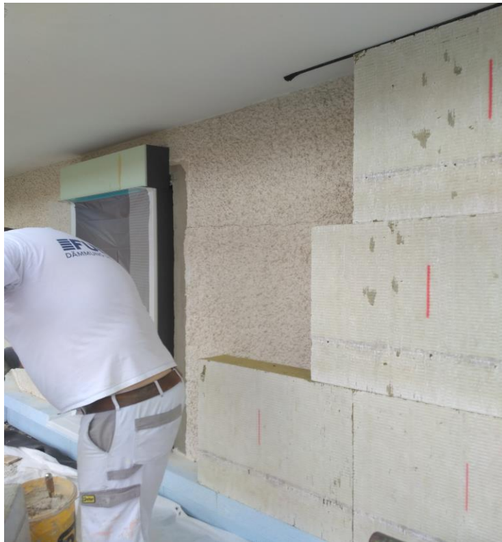
Slika 17: Postavljanje fasade od kamene vune
