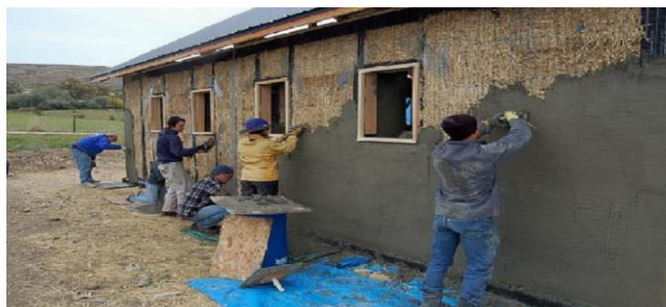
Slika 20: Žbukanje kuće od slame
