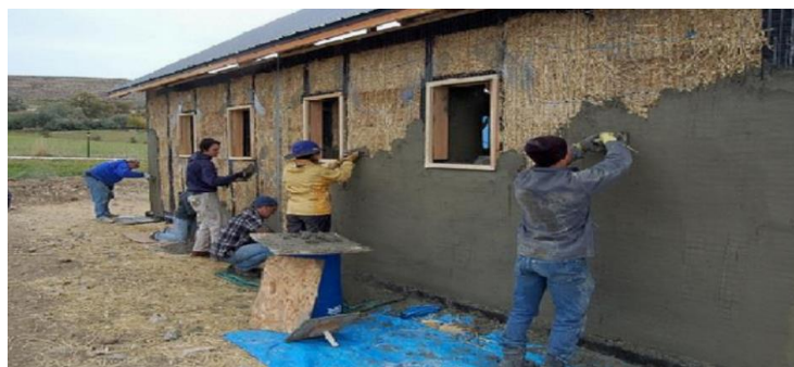
Slika 20: Žbukanje kuće od slame
