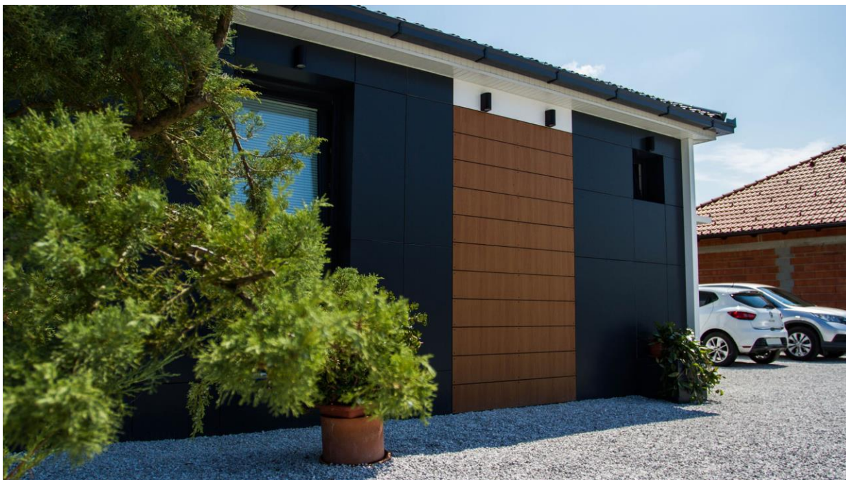
Slika 3.10. Završena Trex kuća Family 80+, lokacija: Slovenija
