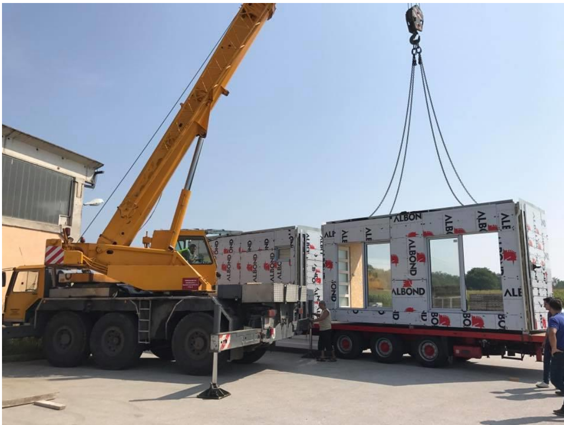
Slika 3.5. Prikaz načina transporta i istovara osnovnih Trex modula, lokacija: Domašinec
