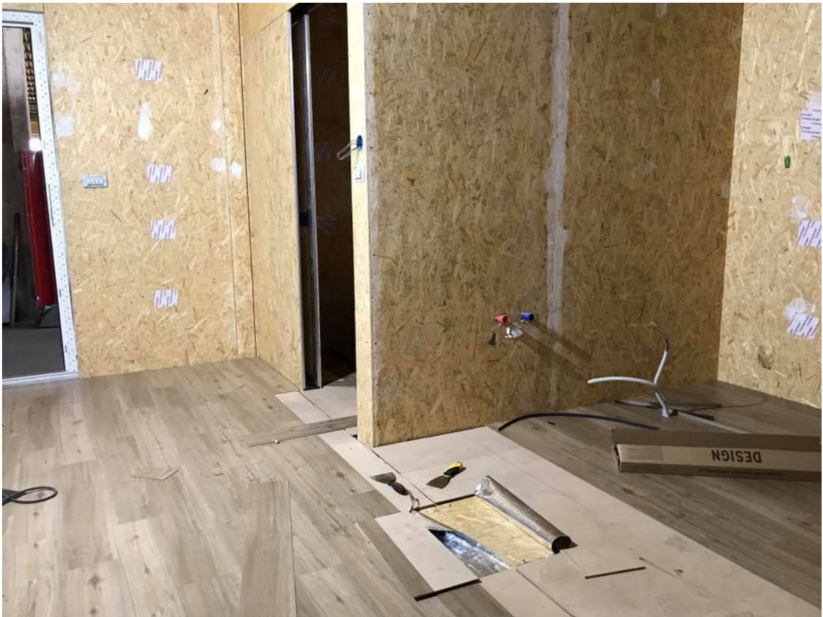
Slika 3.8. Završna ugradnja i obrada unutarnjih podova i zidova, lokacija: Slovenija
