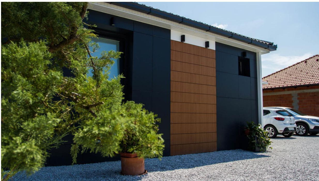
Slika 3.10. Završena Trex kuća Family 80+, lokacija: Slovenija
