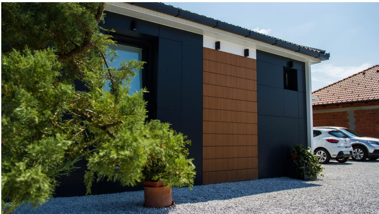
Slika 3.10. Završena Trex kuća Family 80+, lokacija: Slovenija
