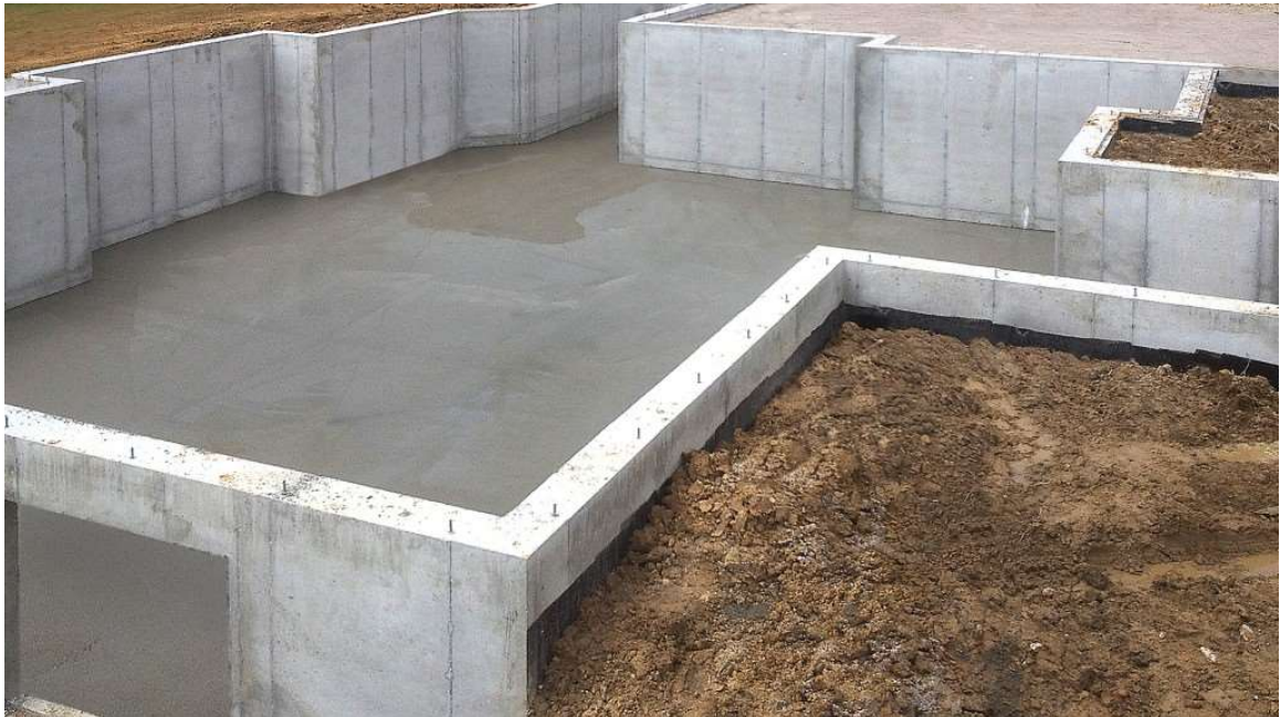
Slika 2.1. Izvedena konstrukcija podrumskog AB zida
