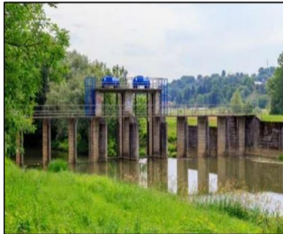
Slika 8. Brana Kućan Ludbreški [21]
