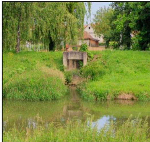
Slika 9. Stanje ulaza u derivacijski kanal[21]
