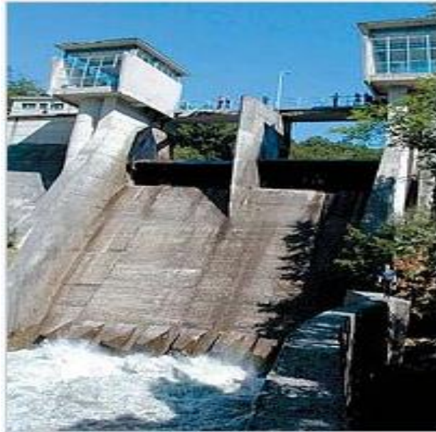
Slika 2. Betonska brana Rijeka
