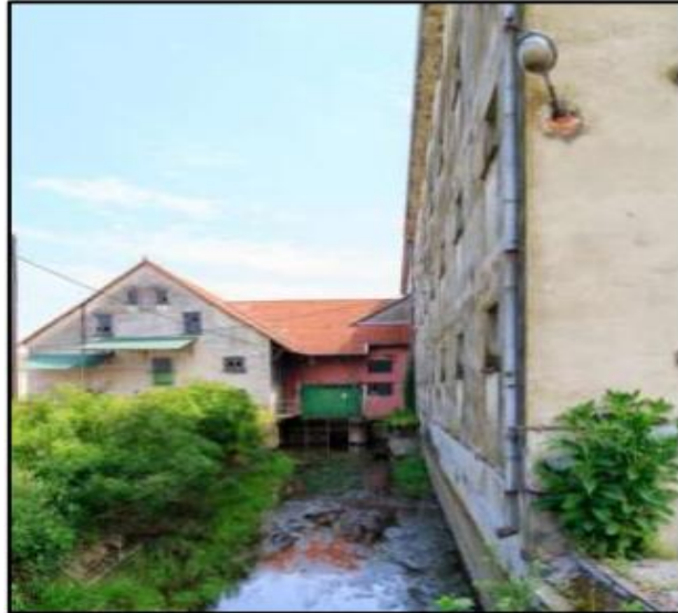
Slika 7. Postojeće stanje strojarnice izvana [21]
