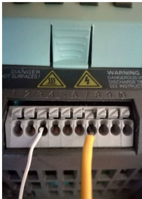
Slika 7.1 Korišteni terminali frekvencijskog pretvarača prema PLC-u
