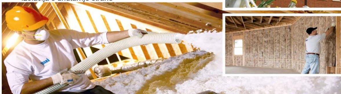
Slika 3.3 Primjeri primjene proizvoda tvrtke u građevinarstvu [11]
