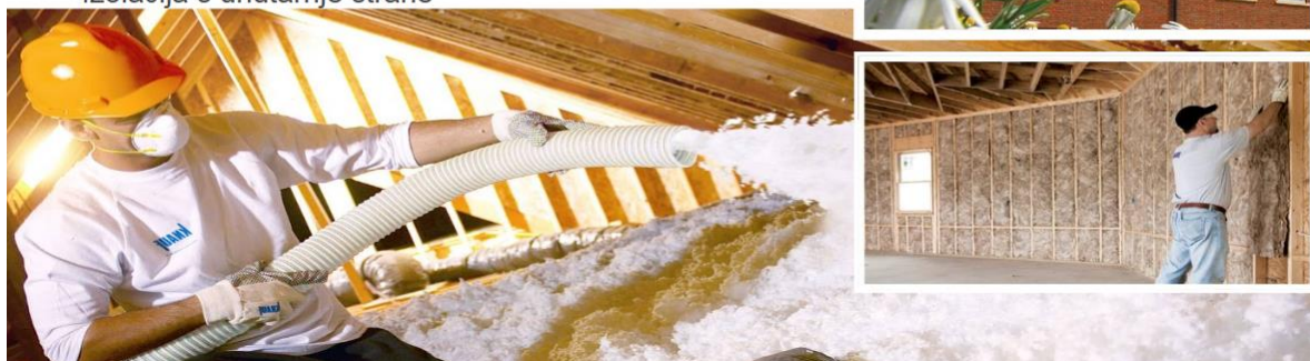
Slika 3.3 Primjeri primjene proizvoda tvrtke u građevinarstvu [11]
